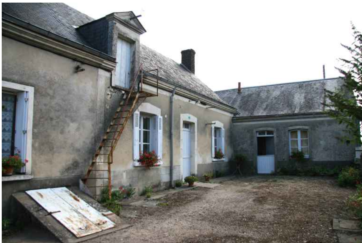
Deuxième logement dans l'alignement.
