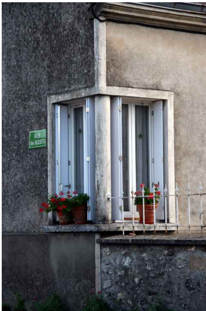
La première maison : fenêtre cassée sur l'angle (1955 ?).
