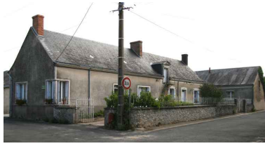
Vue d'ensemble de la maison avec les dépendances en retour. Phot. Jean-Baptiste Darrasse IVR52_20067206821NUCA
