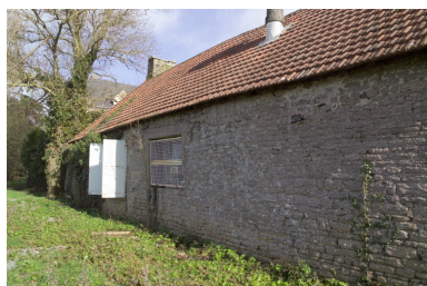
Bâtiment ouest. Vue du mur gouttereau ouest. Phot. Denis Pillet IVR52_20074400319NUCA
