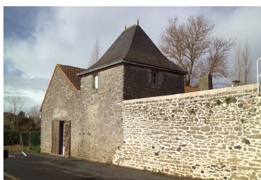
Bâtiment ouest. Vue depuis le sud. Phot. Denis Pillet IVR52_20074400315NUCA
