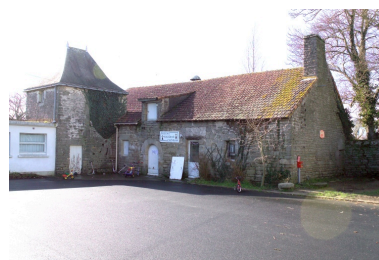
Bâtiment ouest et tour quadrangulaire. Vue depuis l'est. Phot. Denis Pillet IVR52_20074400311NUCA
