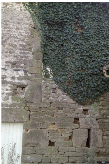
Tour quadrangulaire. Détail de la reprise de maçonnerie. Phot. Denis Pillet IVR52_20074400323NUCA
