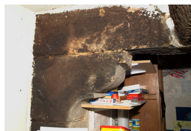
Bâtiment ouest. Cheminée nord. Détail de la console de droite. Phot. Denis Pillet IVR52_20074400327NUCA
