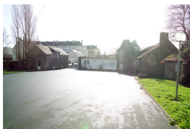
Vue d'ensemble depuis le nord. Phot. Denis Pillet IVR52_20074400312NUCA
