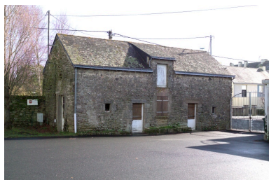
Bâtiment est. Vue de la façade ouest. Phot. Denis Pillet IVR52_20074400310NUCA
