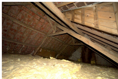
Bâtiment ouest. Vue de la charpente. Phot. Denis Pillet IVR52_20074400325NUCA
