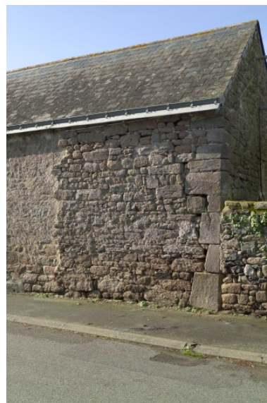
Bâtiment est. Détail du piédroit de l'ancien portail d'entrée. Phot. Denis Pillet IVR52_20074400318NUCA
