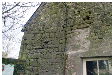
Bâtiment est. Détail de la reprise de construction sur le pignon du bâtiment nord. Phot. Denis Pillet IVR52_20074400313NUCA
