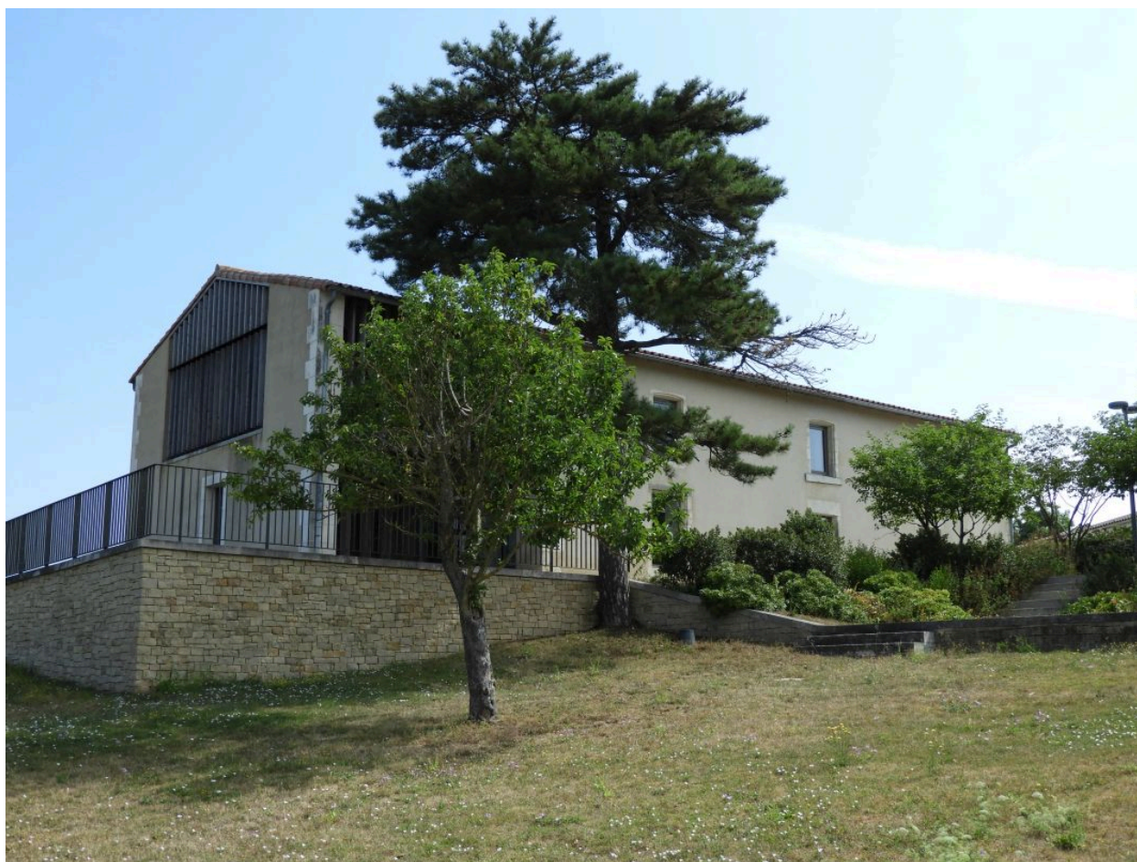
L'ancien prieuré vu depuis le sud-ouest.
