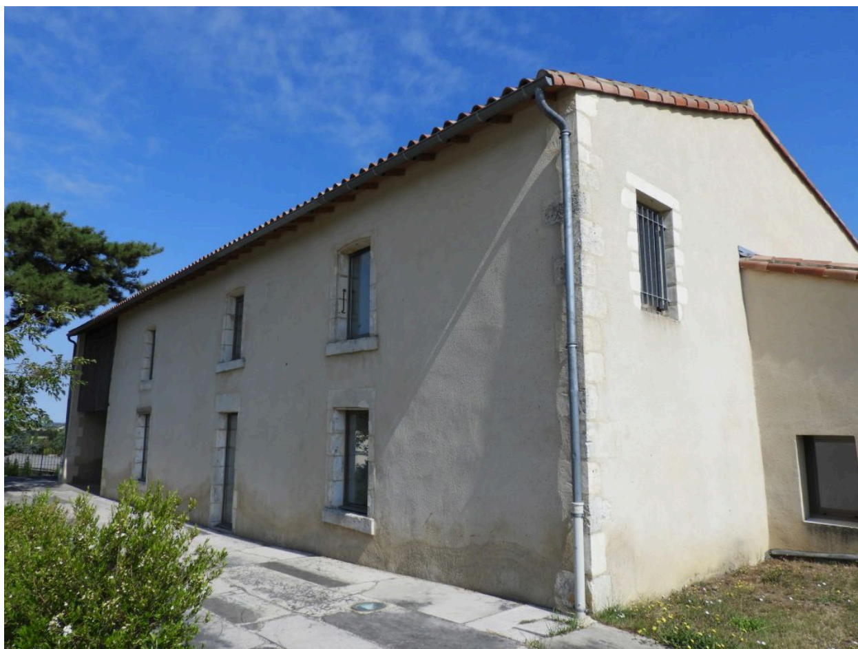
L'ancien logis vu depuis le sud-est.
