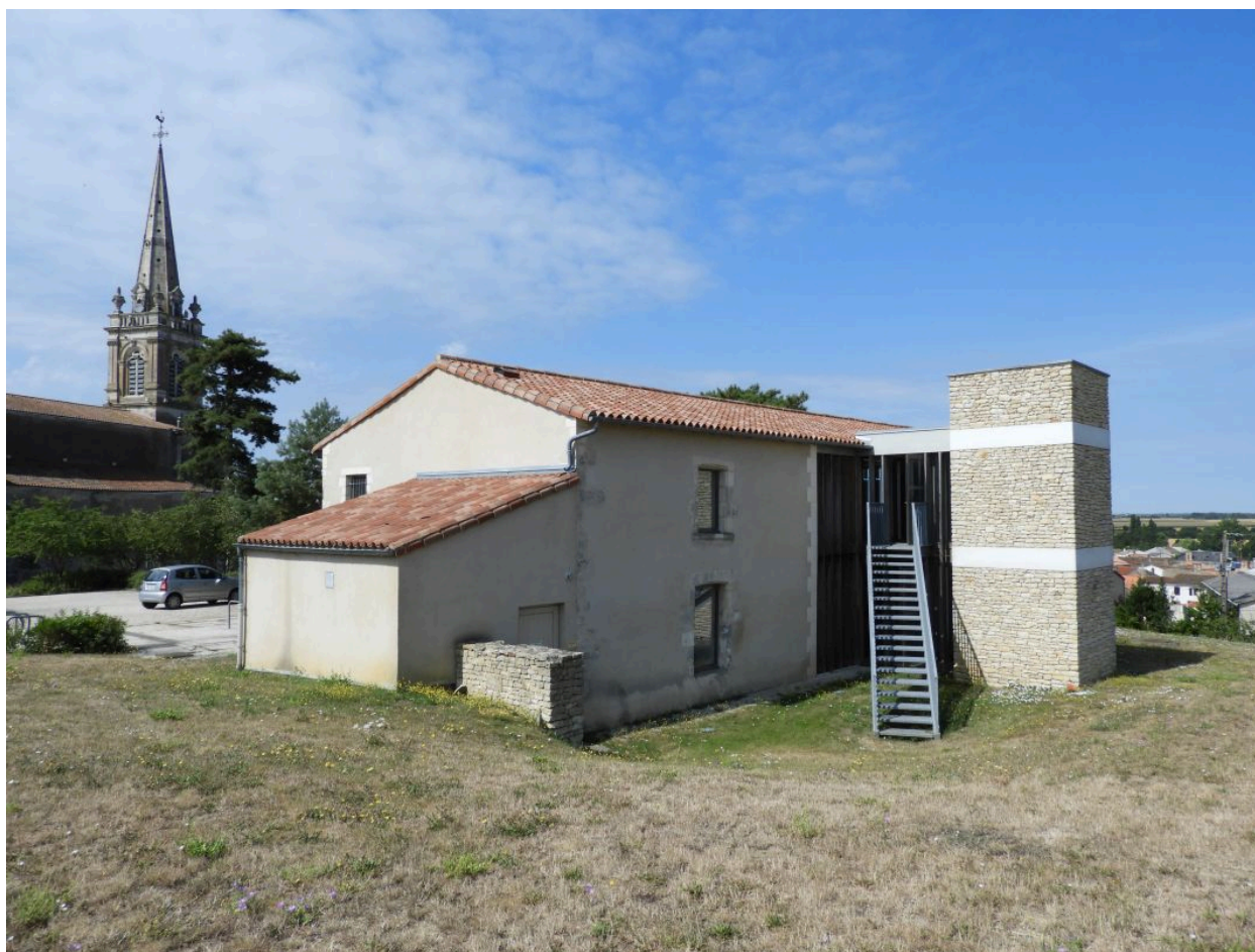
L'ancien prieuré vu depuis le nord-est.
