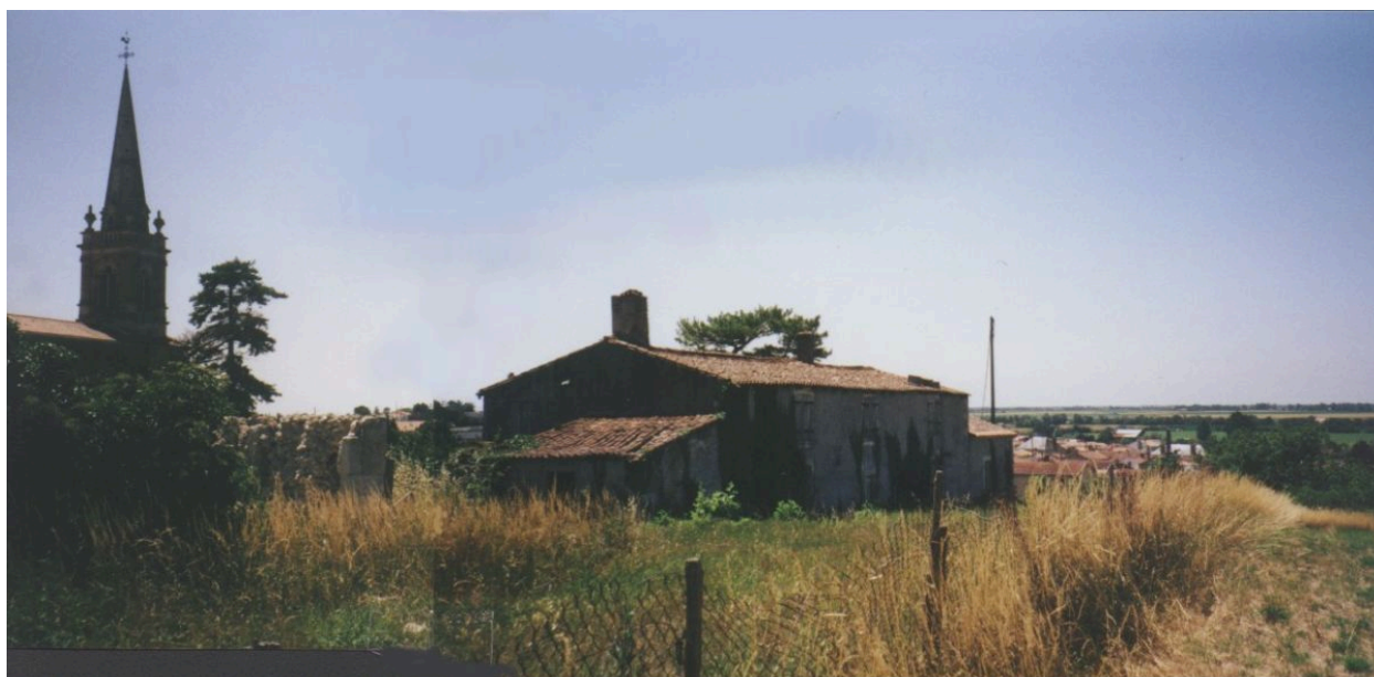
L'ancien prieuré vu depuis le nord vers 2000.
