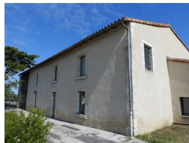
L'ancien logis vu depuis le sud-est. Phot. Yannis Suire IVR52_20188501323NUCA
