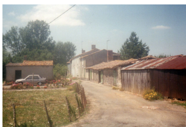
L'ancienne ferme, partie est, vue depuis le sud en 1994. Phot. Yannis (reproduction) Suire IVR52_20198503388NUCA
