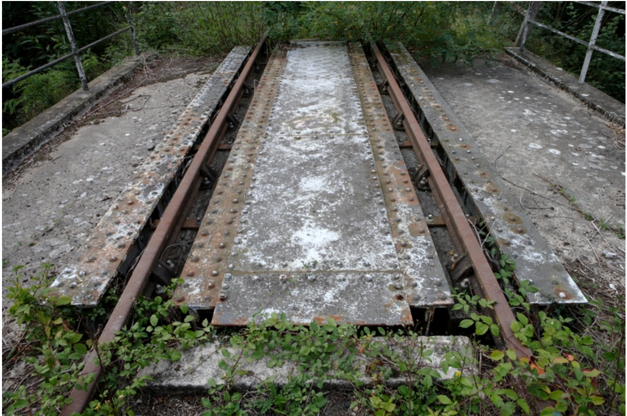
Tablier : accotements, poutres et entretoises, vue supérieure.
