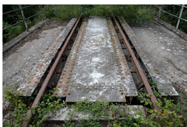
Tablier : accotements, poutres et entretoises, vue supérieure. Phot. Denis Pillet IVR52_20104402216NUCA
