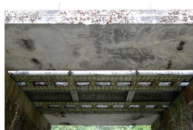
Tablier : accotements, poutres et entretoises, vue inférieure. Phot. Denis Pillet IVR52_20104402213NUCA
