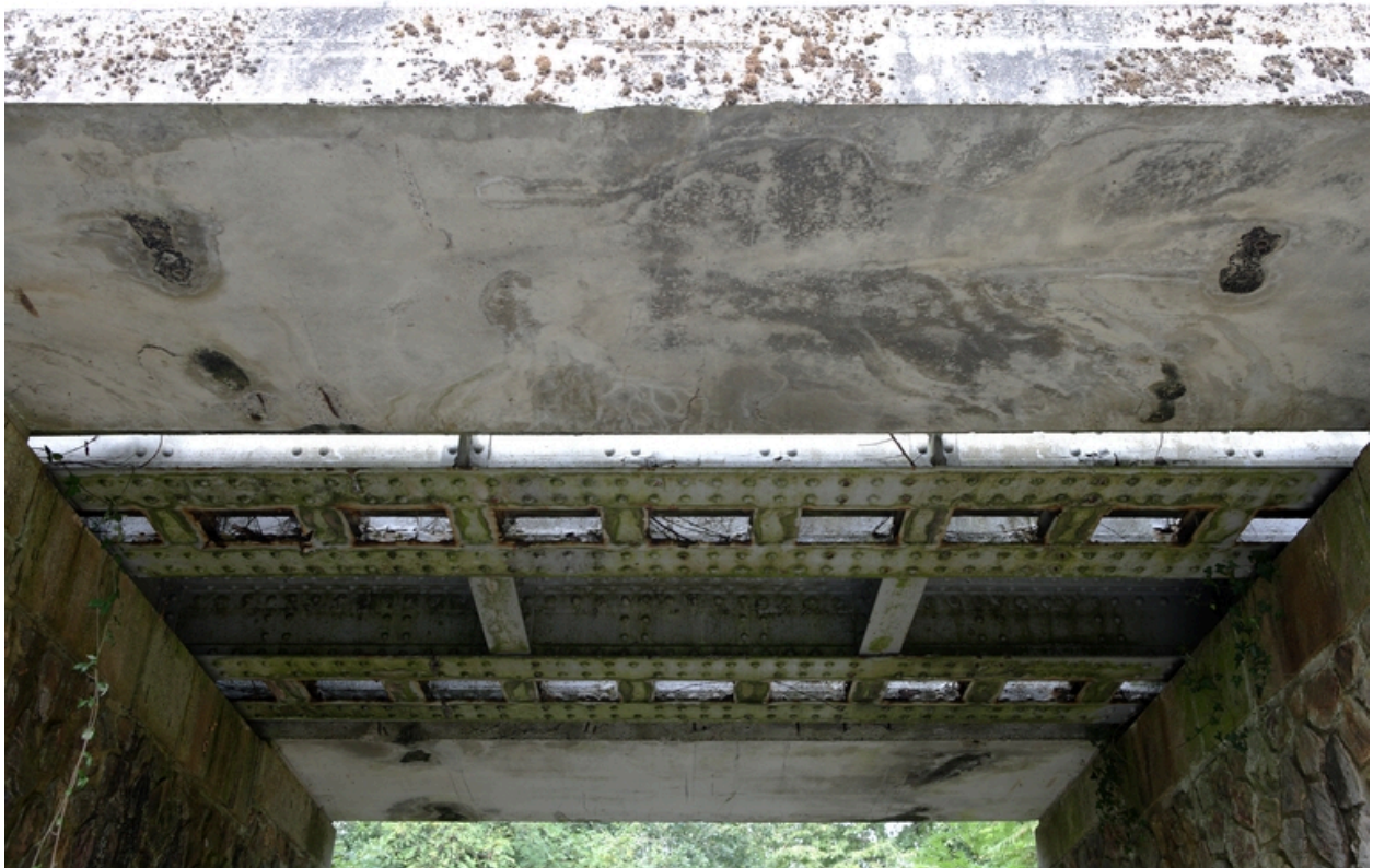
Tablier : accotements, poutres et entretoises, vue inférieure.
