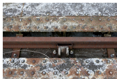
Fixation des rails sur un calage en bois. Phot. Denis Pillet IVR52_20104402218NUCA
