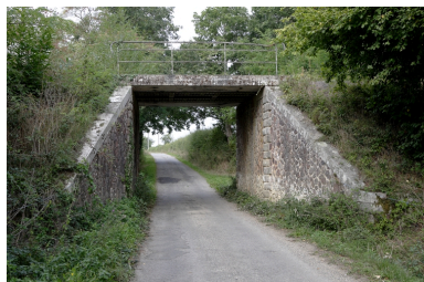
Pont-rail à poutres jumelles. Phot. Denis Pillet IVR52_20104402211NUCA
