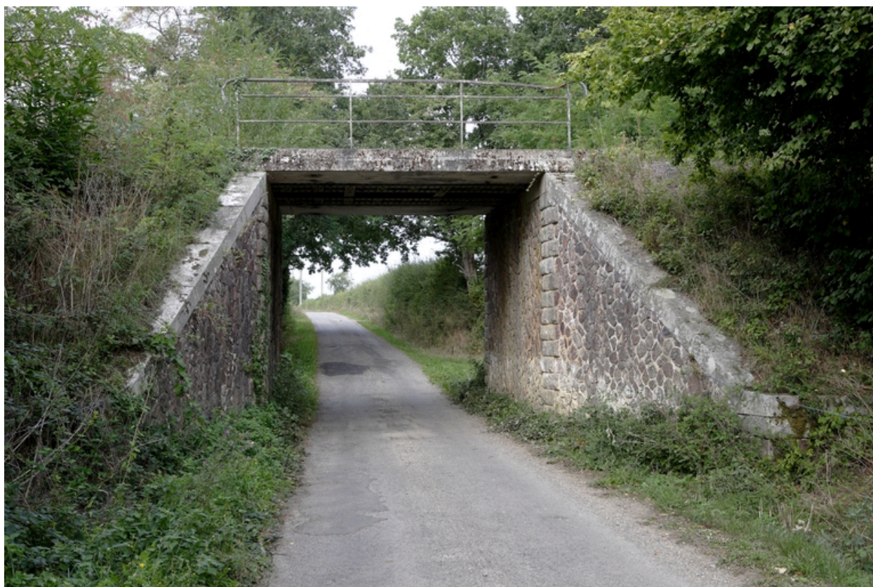
Pont-rail à poutres jumelles.
