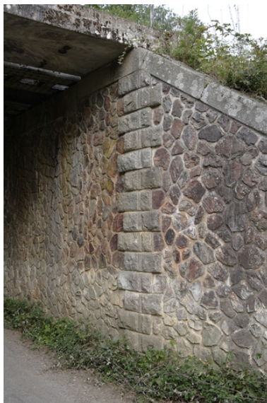
Détail de la maçonnerie et du chaînage d'angle. Phot. Denis Pillet IVR52_20104402212NUCA
