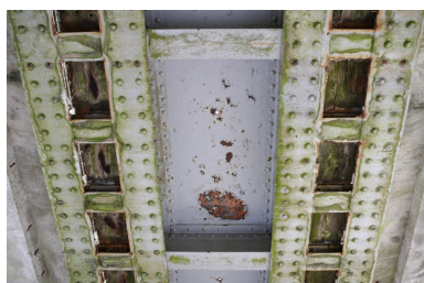
Poutres et entretoises, vue inférieure. Phot. Denis Pillet IVR52_20104402214NUCA
