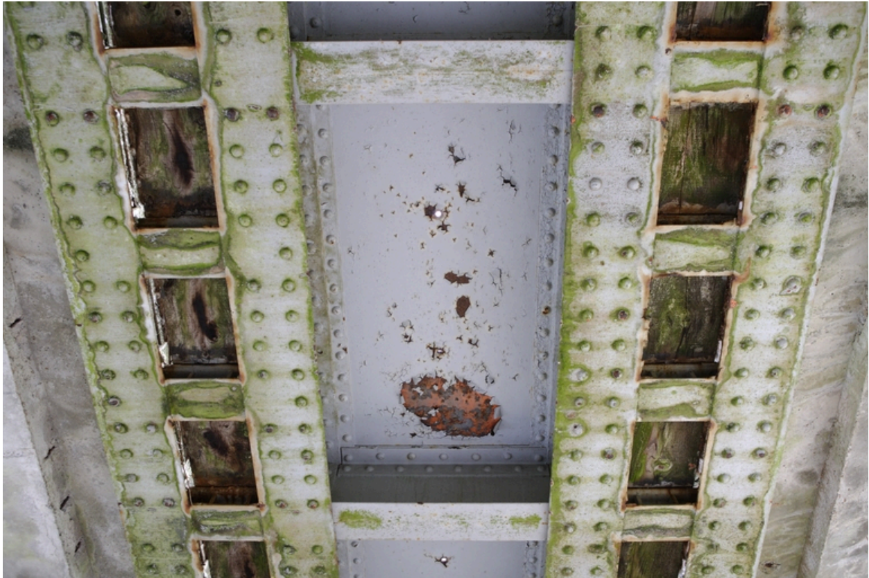
Poutres et entretoises, vue inférieure.
