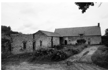
Vue d'ensemble depuis le sud, 1990. Phot. Denis (reproduction) Pillet IVR52_20094401378NUC
