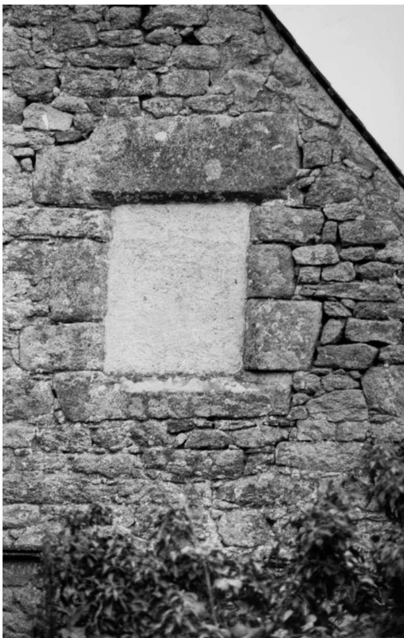
Logis nord. Pignon est. Détail d'une baie, 1990.
