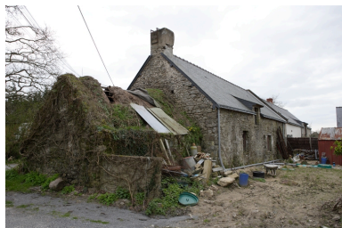
Vue de la façade nord. Phot. Denis Pillet IVR52_20084400585NUCA
