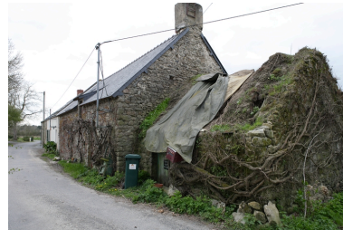
Vue d'ensemble depuis le sud-est. Phot. Denis Pillet IVR52_20084400584NUCA
