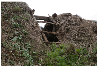
Détail de la couverture en roseau du toit à porcs. Phot. Denis Pillet IVR52_20084400586NUCA
