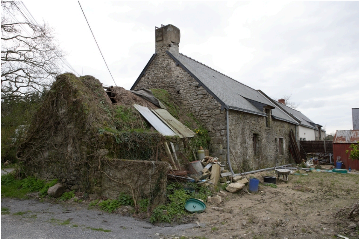
Vue de la façade nord.
