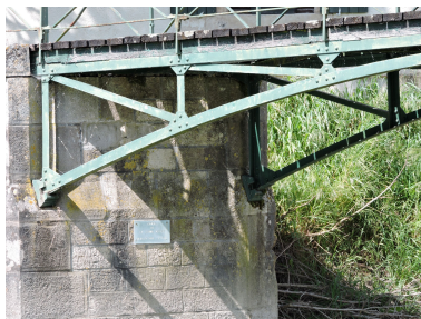
Détail de la passerelle, d'une de ses deux culées et de sa structure en métal. Phot. Yannis Suire IVR52_20218501242NUCA
