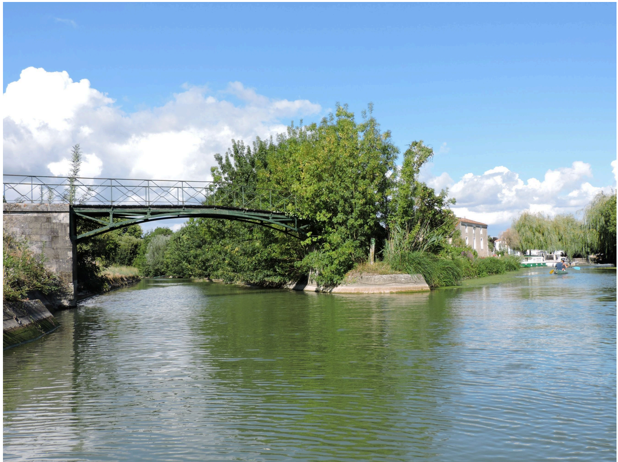
La passerelle vue depuis le sud-ouest.
