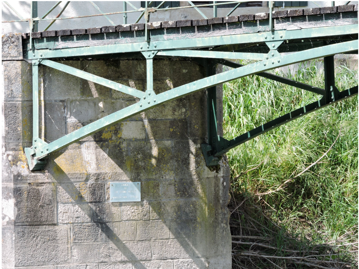
Détail de la passerelle, d'une de ses deux culées et de sa structure en métal.
