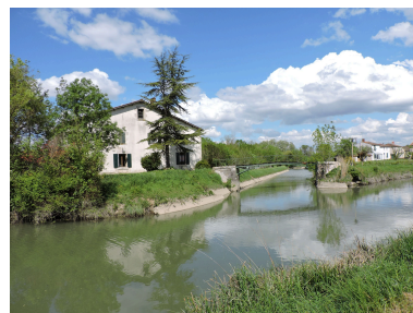
La passerelle, à l'embouchure de la Jeune Autise, vue depuis le sud-ouest. Phot. Yannis Suire IVR52_20218501237NUCA
