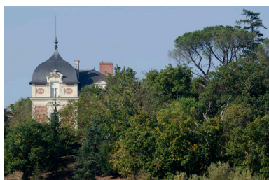
Vue depuis l'est. Phot. Bruno Rousseau IVR52_20134901559NUCA
