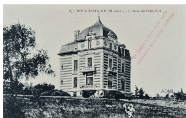
Vue depuis le jardin. Carte postale. 1er quart 20e siècle. Repro. Bruno Rousseau IVR52_20174900500NUCA
