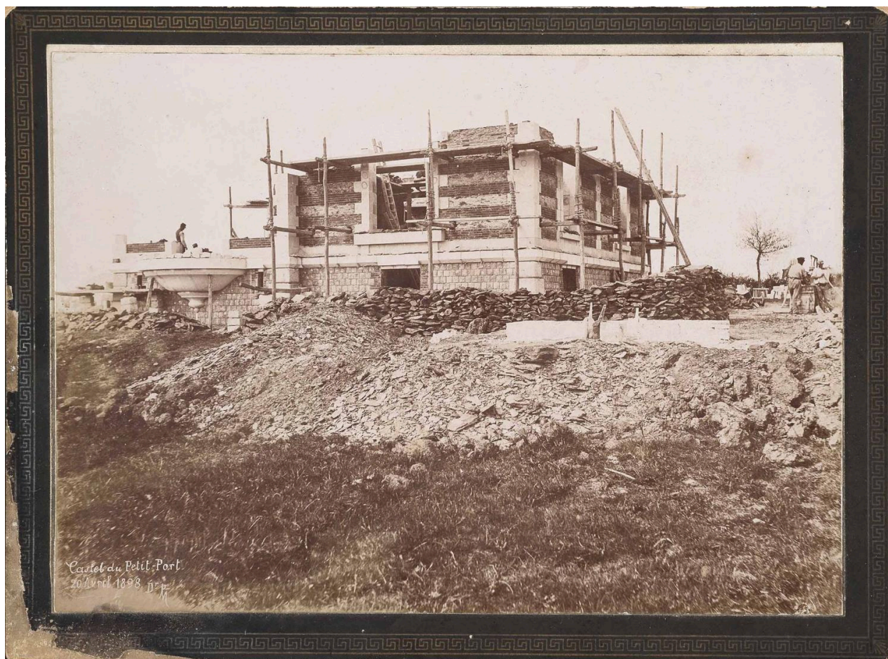
Construction du château du Petit-Port.
