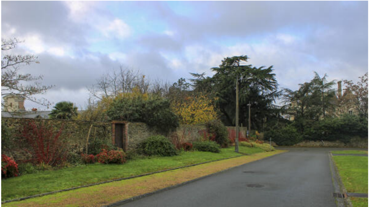
Le mur de l'ancien potager.
