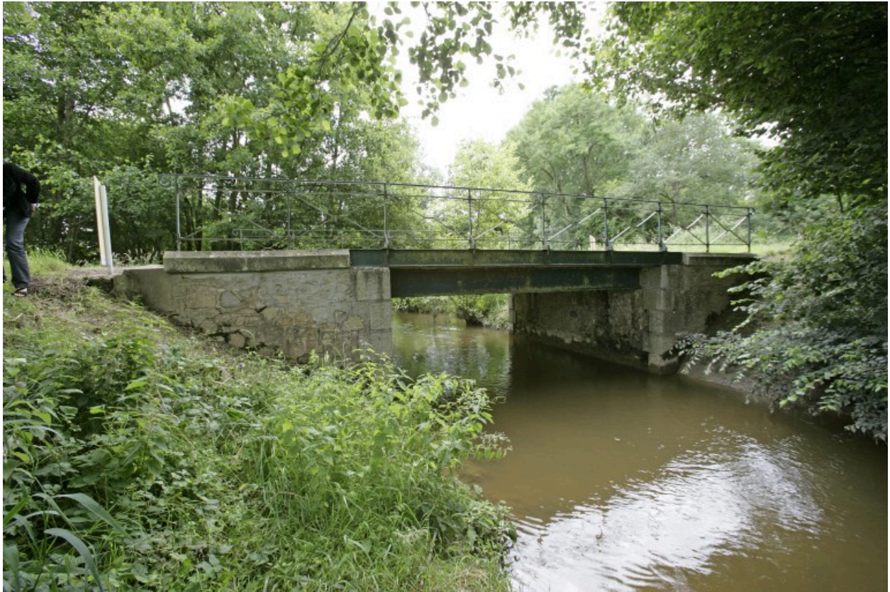
Vue d'amont depuis la rive gauche.
