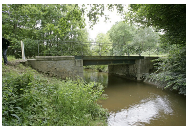
Vue d'amont depuis la rive gauche. Phot. François Lasa IVR52_20075300406NUCA
