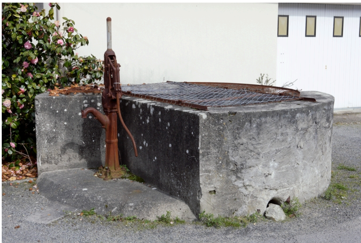
Puits commun (rue Saint-Cado).
