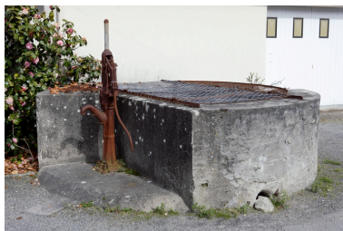
Puits commun (rue Saint-Cado).
