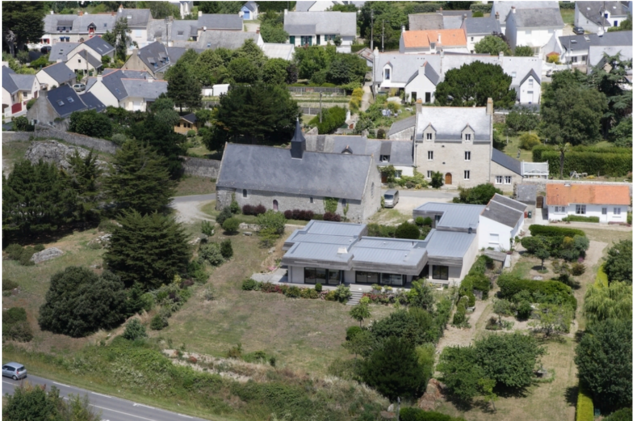
Vue aérienne de l'écart de Careil depuis le sud.
