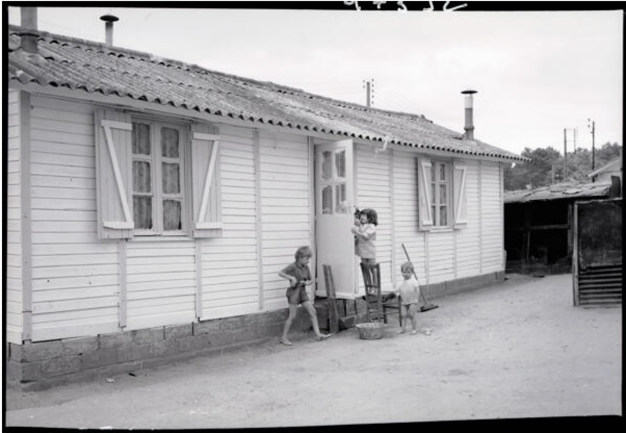
Photographie d'un baraquement en bois avec solin de brique au quartier des Bruyères.
