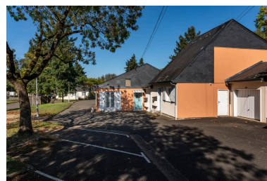
Vue de maisons du quartier des Bruyères, avenue des platanes. Phot. Thierry Seldubuisson IVR52_20227201244NUCA
