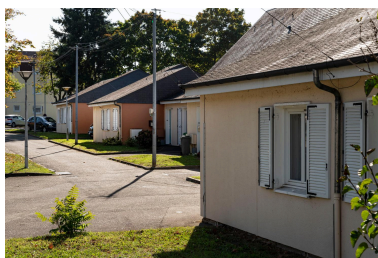
Vue de maisons du quartier des Bruyères cour des érables. Phot. Thierry Seldubuisson IVR52_20227201246NUCA
