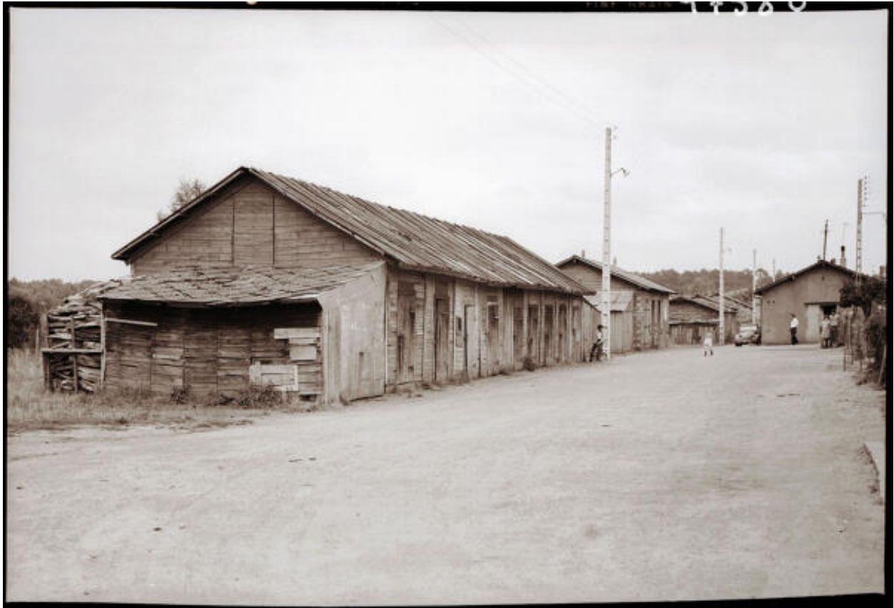
Photographie d'une rue du quartier des Bruyères avant sa réhabilitation.
