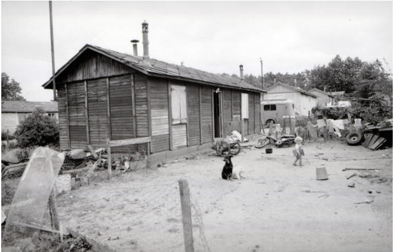
Photographie d'un baraquement au quartier des Bruyères avec solin de béton.
