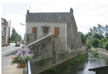
Façade principale vue depuis l'ouest. Phot. François Lasa IVR52_20035302339NUCA
