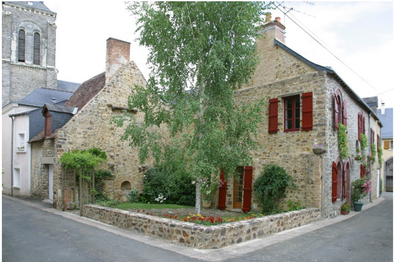
L'emplacement de la maison détruite. A gauche les arrachements de la cheminée.
