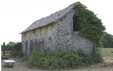
La porcherie. Phot. François Lasa IVR52_20045301963NUCA
