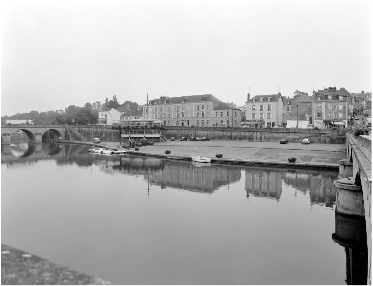
Le quai de Waiblingen, situé sur la rive gauche entre le pont Mac Racken et le pont Notre Dame, et la partie amont du port vus depuis la rive opposée. A gauche, le pont Mac Racken ; à droite, le pont Notre Dame.
