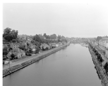
Vue générale des quais et des deux ponts depuis le viaduc, en aval. A
