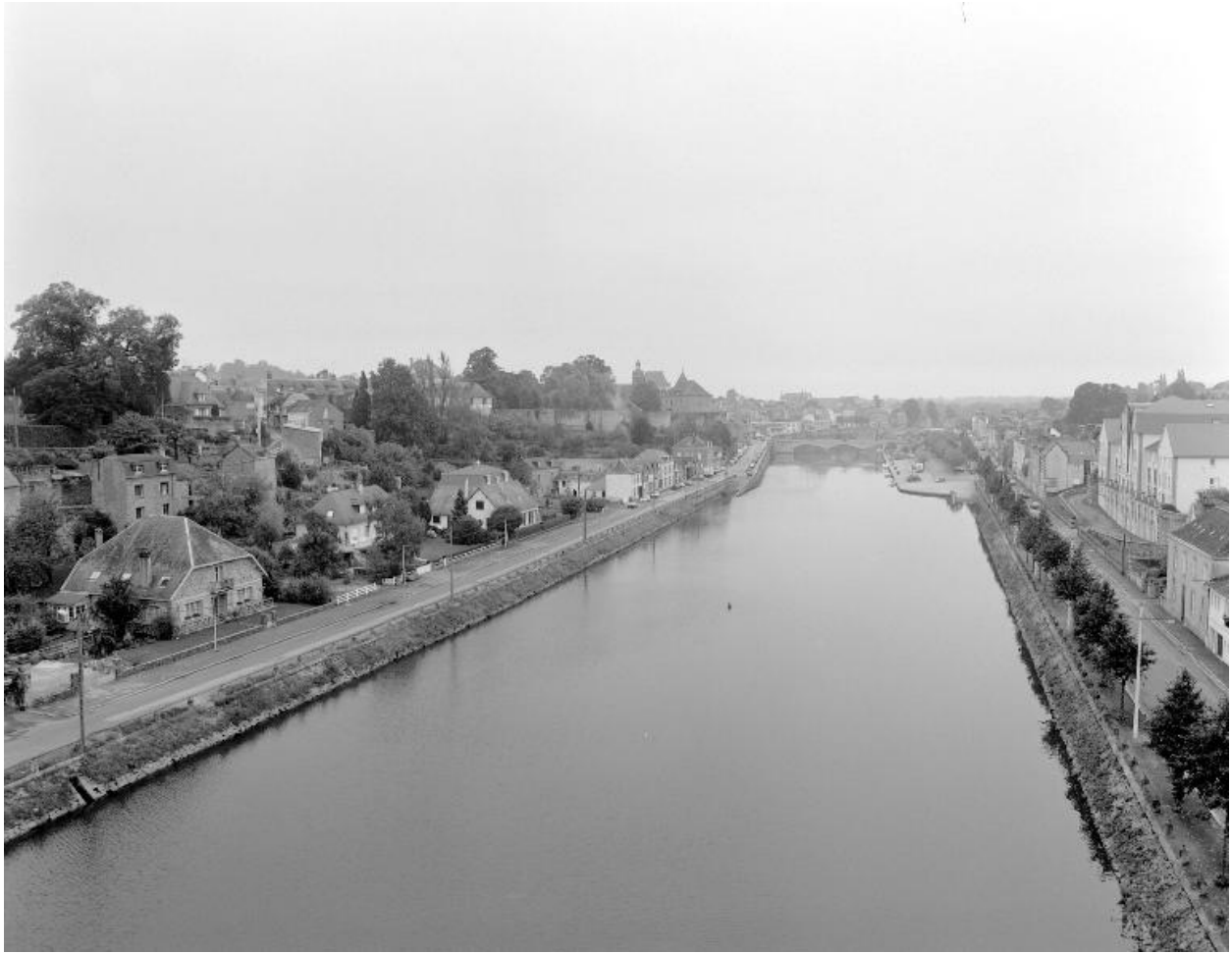
Vue générale des quais et des deux ponts depuis le viaduc, en aval. A gauche, le quai Carnot ; à droite, le quai de la République et le port.
