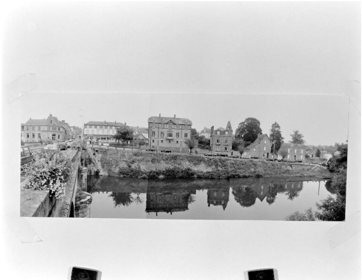
Le quai situé rive droite en amont du pont Mac Racken.
