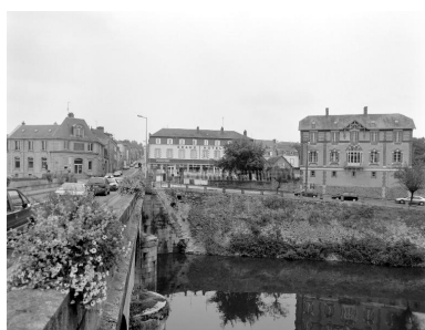
Le quai situé rive droite en amont du pont Mac Racken. Partie aval. Phot. François Lasa IVR52_20025301220X
