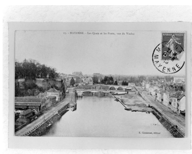
Vue générale des quais et des deux ponts depuis le viaduc, en aval.
