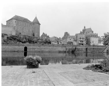
Le quai Carnot, situé sur la rive droite entre le pont Notre Dame et le viaduc, vu du port. Partie amont. Phot. François Lasa IVR52_20025301218X
