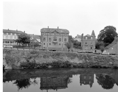
Le quai situé rive droite en amont du pont Mac Racken. Partie centrale. Phot. François Lasa IVR52_20025301221X
