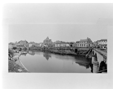
Le quai Devizes, situé sur la rive droite entre les deux ponts, vu du pont Mac Racken. Phot. François Lasa IVR52_20025301676X
