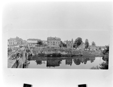
Le quai situé rive droite en amont du pont Mac Racken. Phot. François Lasa IVR52_20025301677X
