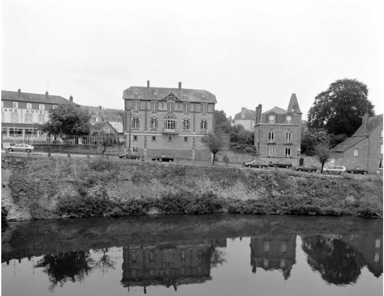
Le quai situé rive droite en amont du pont Mac Racken. Partie centrale.
