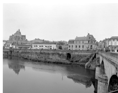
Le quai Devizes, situé sur la rive droite entre les deux ponts, vu du pont Mac Racken. Partie amont. Phot. François Lasa IVR52_20025301212X
