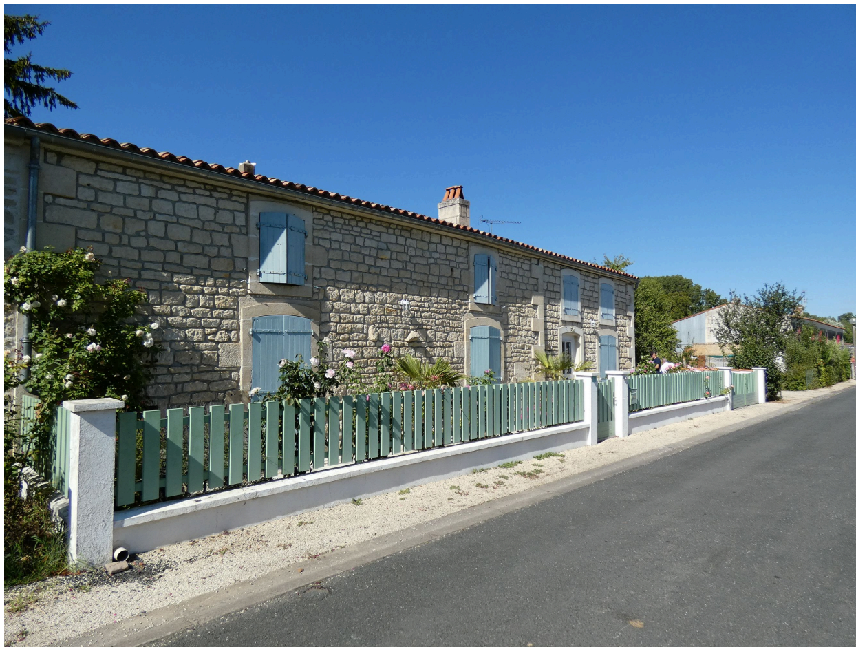
L'ancienne ferme vue depuis le sud-ouest.
