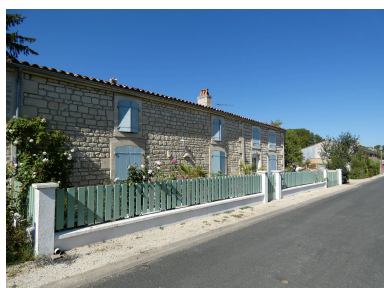
L'ancienne ferme vue depuis le sud-ouest. Phot. Yannis Suire IVR52_20228501781NUCA
