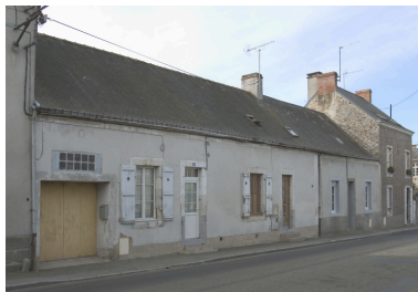
Vue depuis la rue. Phot. François Lasa IVR52_20045303116NUCA
