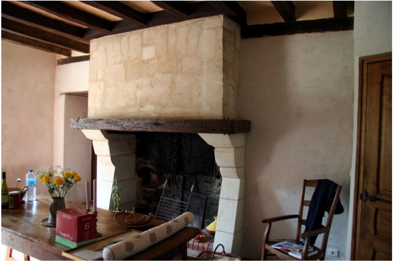
Salle centrale : vestiges d'une cheminée à hotte droite en pierre très recomposée.
