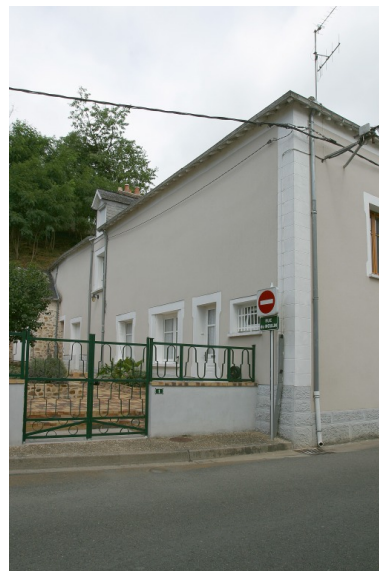
Elévation sud sur cour et élévation est sur rue. Phot. François Lasa IVR52_20035302370NUCA
