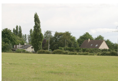
Vue d'ensemble depuis la route au nord-est : la maison ancienne et la maison moderne. Phot. François Lasa IVR52_20035302249NUCA
