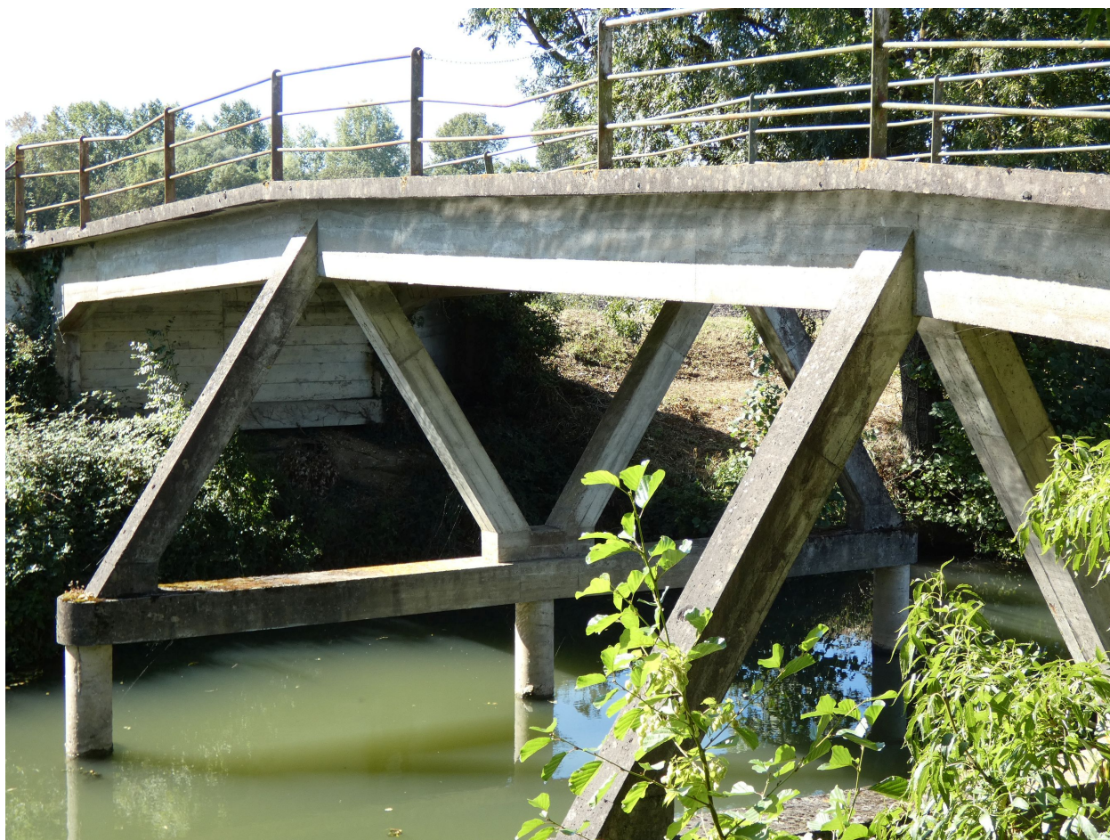
Détail des piles centrales.
