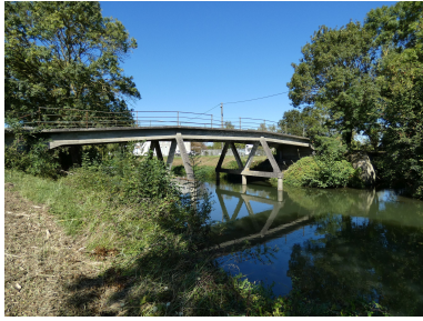
Le pont vu depuis le sud, côté amont. Phot. Yannis Suire IVR52_20228500462NUCA
