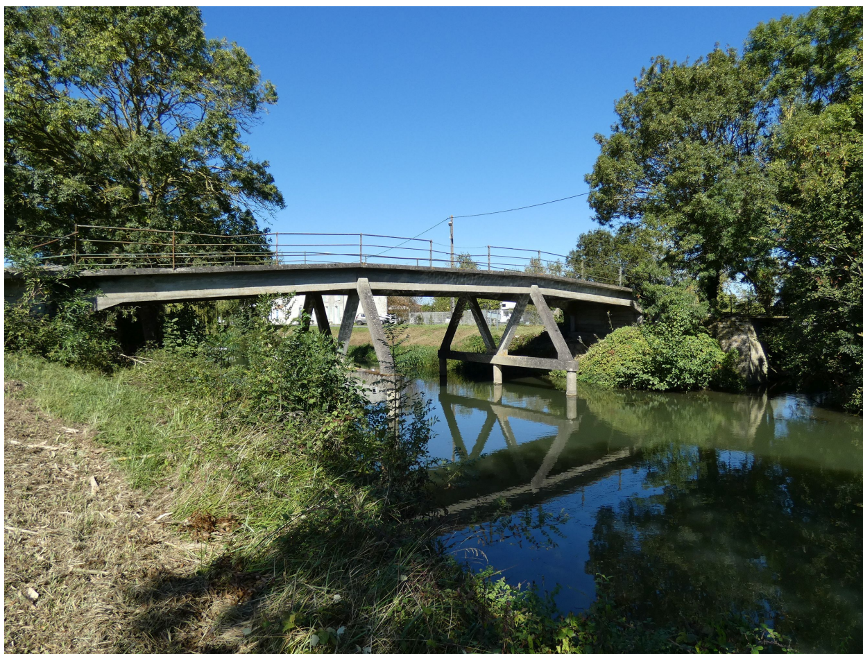
Le pont vu depuis le sud, côté amont.
