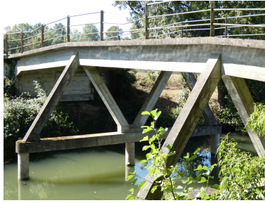
Détail des piles centrales. Phot. Yannis Suire IVR52_20228500465NUCA
