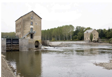
Vue d'ensemble du site depuis la rive droite en aval pendant les écourées de 2009 : écluse, moulin rive droite (à Saint-Sulpice), pertuis, barrage, moulin rive gauche (à Villiers-Charlemagne). Phot. Yves Guillotin IVR52_20095300479NUCA
