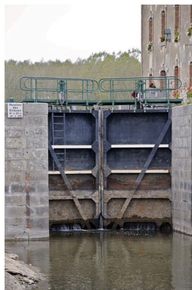
La porte d'aval de l'écluse, pendant les écourues de 2009. Phot. Yves Guillotin IVR52_20095300481NUCA
