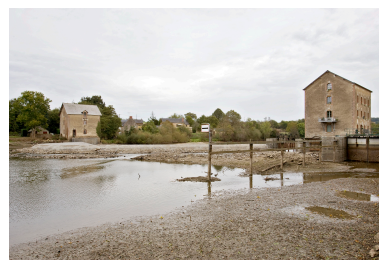
Vue d'ensemble du site depuis la rive droite en amont pendant les écourées de 2009 : moulin rive gauche (à Villiers-Charlemagne), barrage, pertuis, moulin rive droite (à Saint-Sulpice), écluse. Au-devant du barrage actuel, vestiges du barrage détruit en 1876. Phot. Yves Guillotin IVR52_20095300477NUCA
