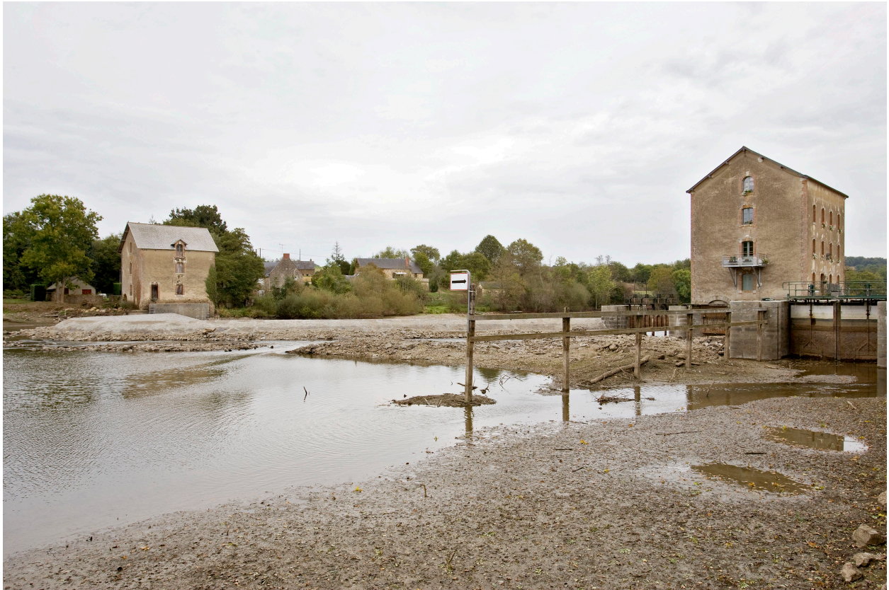
Vue d'ensemble du site depuis la rive droite en amont pendant les écoures de 2009 : moulin rive gauche (à Villiers-Charlemagne), barrage, pertuis, moulin rive droite (à Saint-Sulpice), écluse. Au-devant du barrage actuel, vestiges du barrage détruit en 1876.
