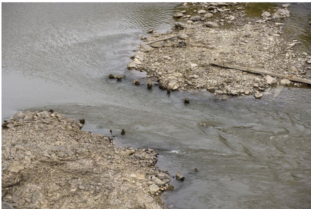
Les vestiges de la porte marinière détruite en 1876, vus pendant les écourues de 2009.
