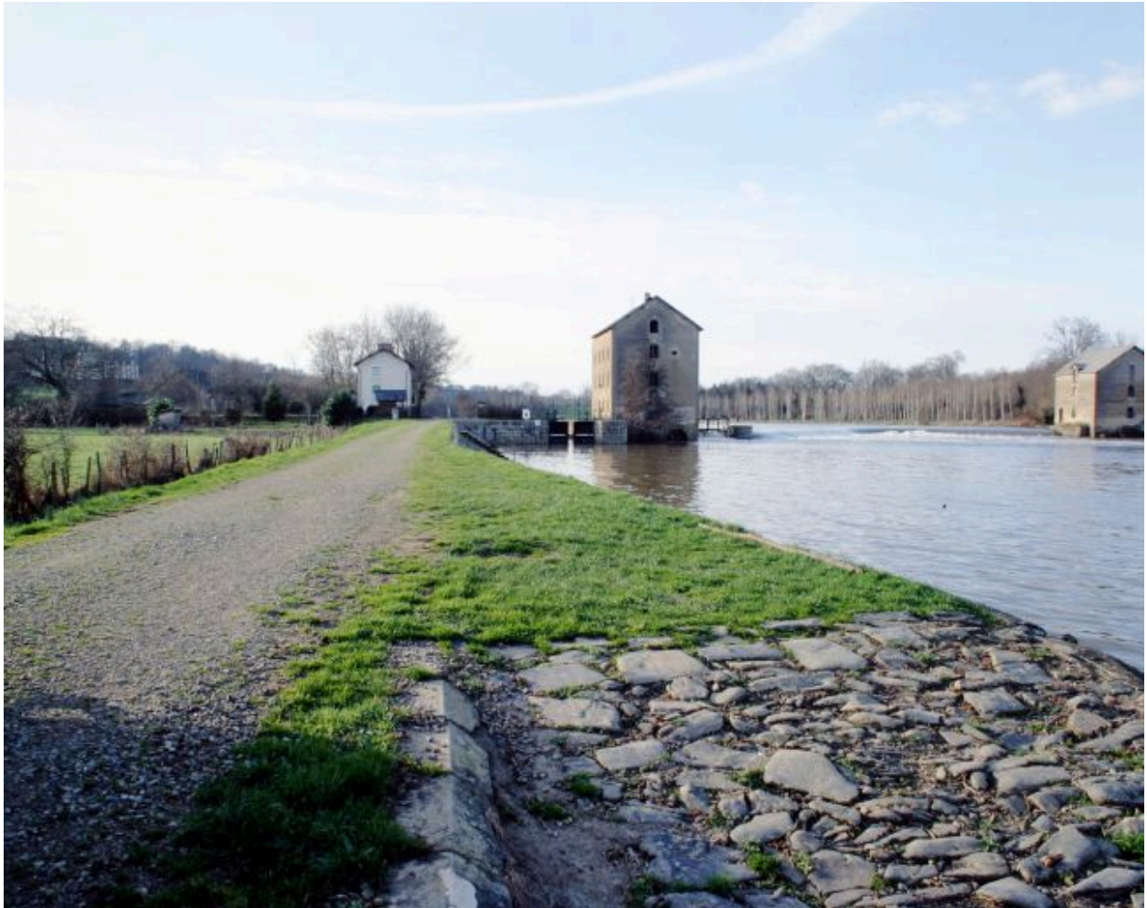
Vue d'ensemble du site depuis la rive droite en aval : château de la Rongère, maison du meunier, maison éclusière, écluse, moulin rive droite (à Saint-Sulpice), pertuis, barrage, moulin rive gauche (à Villiers-Charlemagne).
