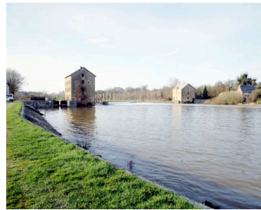
Vue d'ensemble du site depuis la rive droite en aval : écluse, moulin rive droite (à Saint-Sulpice), pertuis, barrage, moulin rive gauche (à Villiers-Charlemagne). Phot. François Lasa IVR52_20025300427XA
