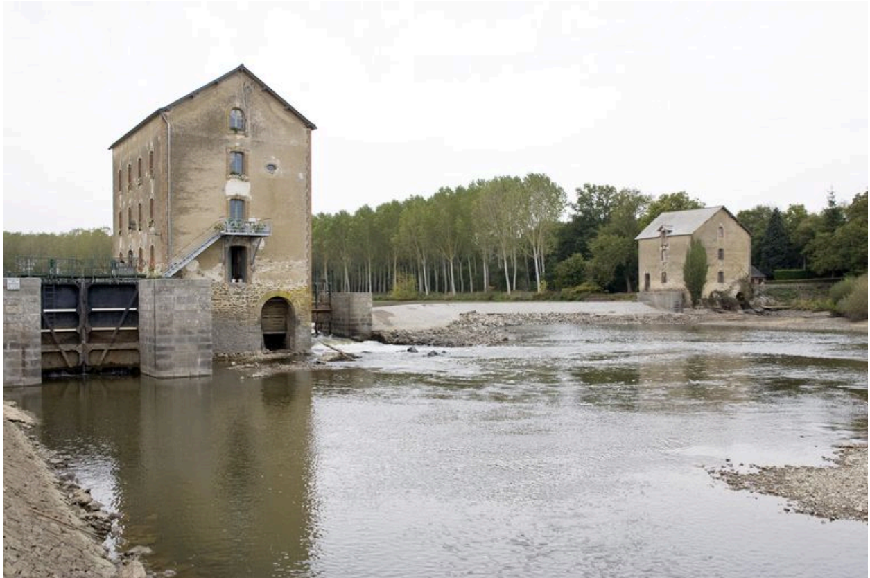
Vue d'ensemble du site depuis la rive droite en aval pendant les écourues de 2009 : écluse, moulin rive droite (à Saint-Sulpice), pertuis, barrage, moulin rive gauche (à Villiers-Charlemagne).
