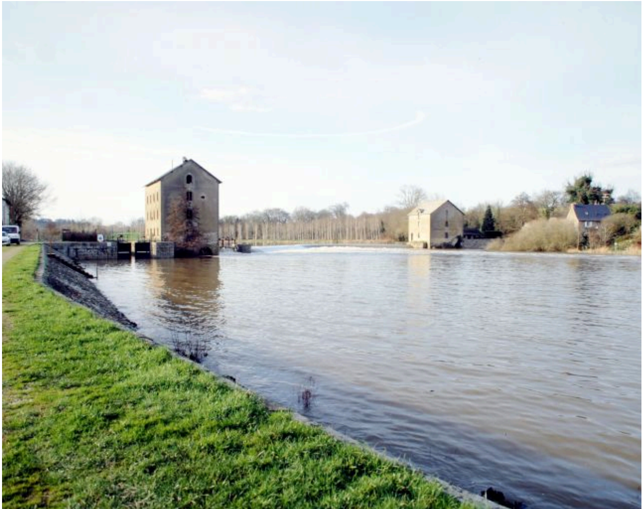
Vue d'ensemble du site depuis la rive droite en aval : écluse, moulin rive droite (à Saint-Sulpice), pertuis, barrage, moulin rive gauche (à Villiers-Charlemagne).
