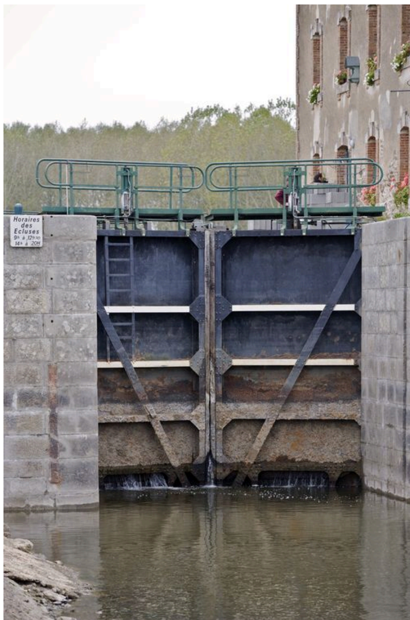
La porte d'aval de l'écluse, pendant les écourues de 2009.
