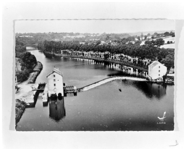
Vue aérienne d'ensemble du site : écluse, moulin situé rive droite (Saint-Sulpice), pertuis, barrage, moulin situé rive gauche (Villiers-Charlemagne). Autr. LAPIE, Repro. François Lasa IVR52_20015300691X
