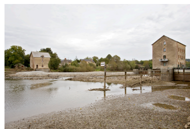
Vue d'ensemble du site depuis la rive droite en amont pendant les écoures de 2009 : moulin rive gauche (à Villiers-Charlemagne), barrage, pertuis, moulin rive droite (à Saint-Sulpice), écluse. Au-devant du barrage actuel, vestiges du barrage détruit en 1876. Phot. Yves Guillotin IVR52_20095300477NUCA
