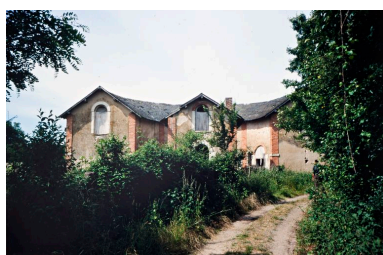
Façade postérieure : les écuries en fer à cheval et le logement au centre. Phot. Christine Toulhier IVR52_20137200003NUCA
