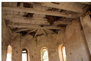
Plafond du logement. Phot. Jean-Baptiste Darrasse IVR52_20097200619NUCA
