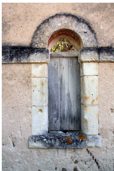
Petite baie de part et d'autre de l'entrée d'une écurie. Phot. Jean-Baptiste Darrasse IVR52_20097200611NUCA
