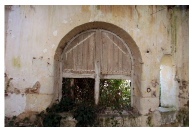
Double baie d'une écurie vers le centre. Phot. Jean-Baptiste Darrasse IVR52_20097200612NUCA
