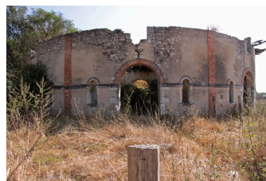
Façade antérieure, vue prise dans l'axe. Phot. Jean-Baptiste Darrasse IVR52_20097200609NUCA
