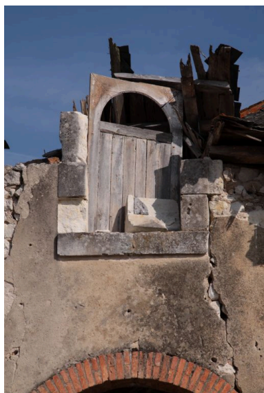
Lucarne passante du comble à surcroît. Phot. Jean-Baptiste Darrasse IVR52_20097200614NUCA
