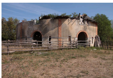
Vue latérale. Phot. Jean-Baptiste Darrasse IVR52_20097200613NUCA
