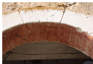
Couronnement de baie : fausses briques peintes sur des claveaux de tufeau. Phot. Jean-Baptiste Darrasse IVR52_20097200620NUCA
