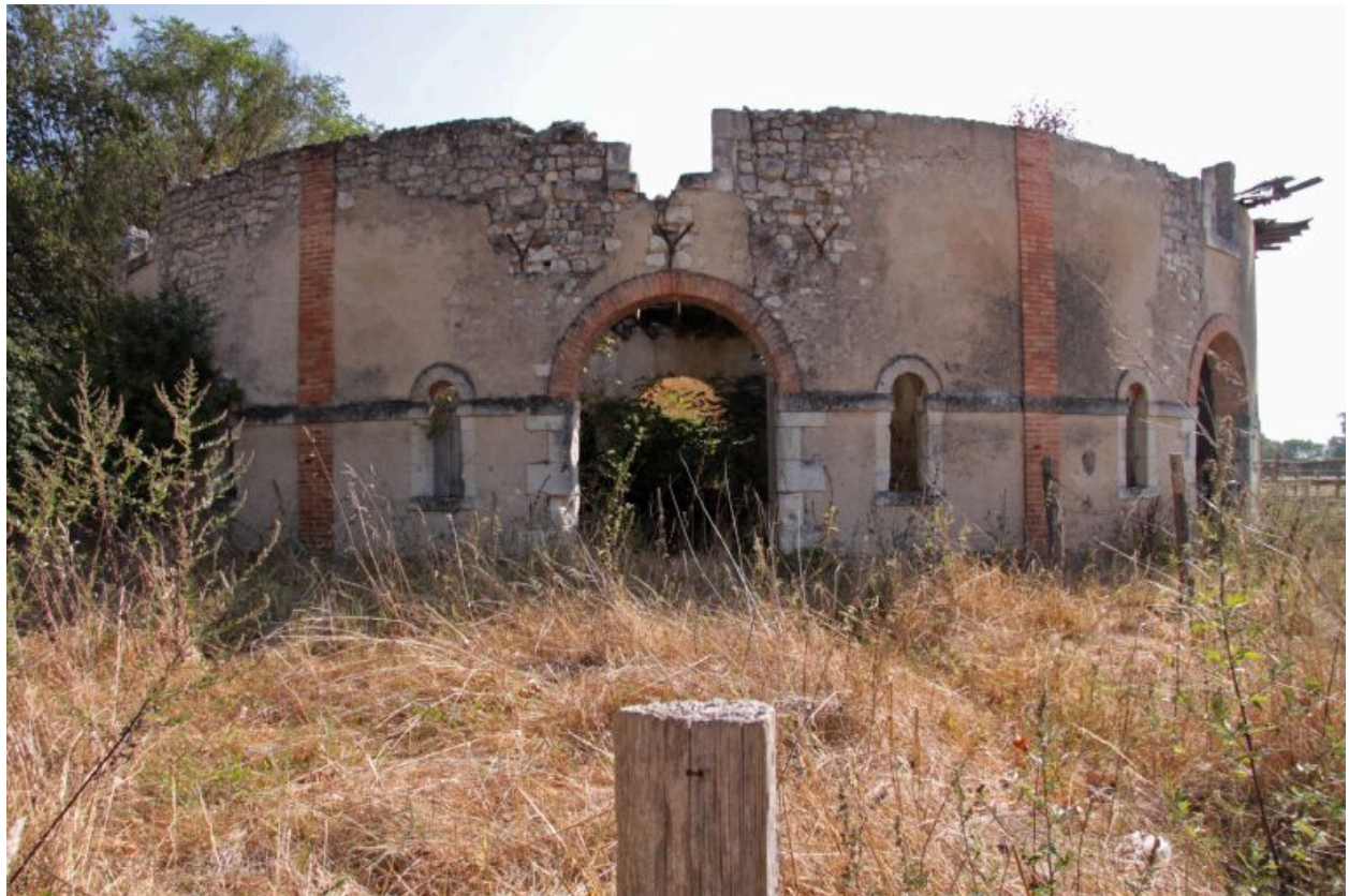
Façade antérieure, vue prise dans l'axe.
