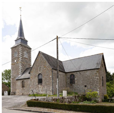
Flanc sud de l'église de Brétignolles-le-Moulin. Phot. Yves Guillotin IVR52_20215300643NUCA
