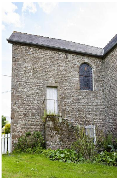
Bras gauche du transept, accès direct entre la sacristie et le jardin du presbytère. Phot. Yves Guillotin IVR52_20215300645NUCA
