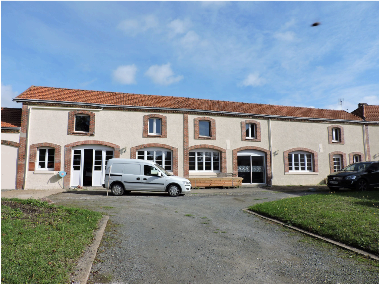
Les communs, ancien laboratoire de pâtisserie, vus depuis l'ouest.
