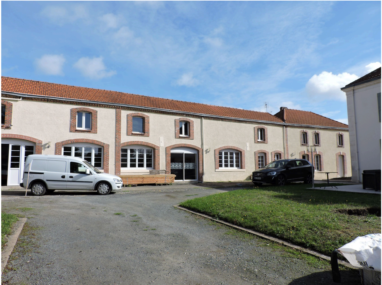
Les communs, ancien laboratoire de pâtisserie, vus depuis le nord-ouest.
