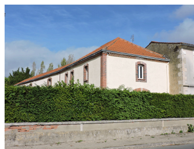
Les communs vus depuis le sud-ouest. Phot. Yannis Suire IVR52_20218500140NUCA
