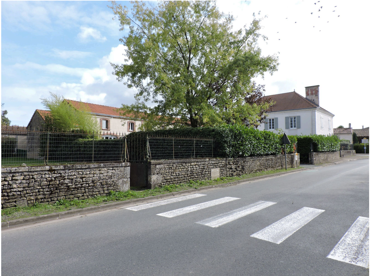
La propriété vue depuis le nord-ouest.
