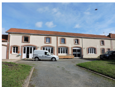
Les communs, ancien laboratoire de pâtisserie, vus depuis l'ouest. Phot. Yannis Suire IVR52_20218500141NUCA
