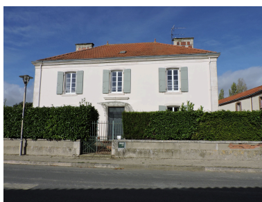
La maison vue depuis le sud. Phot. Yannis Suire IVR52_20218500139NUCA
