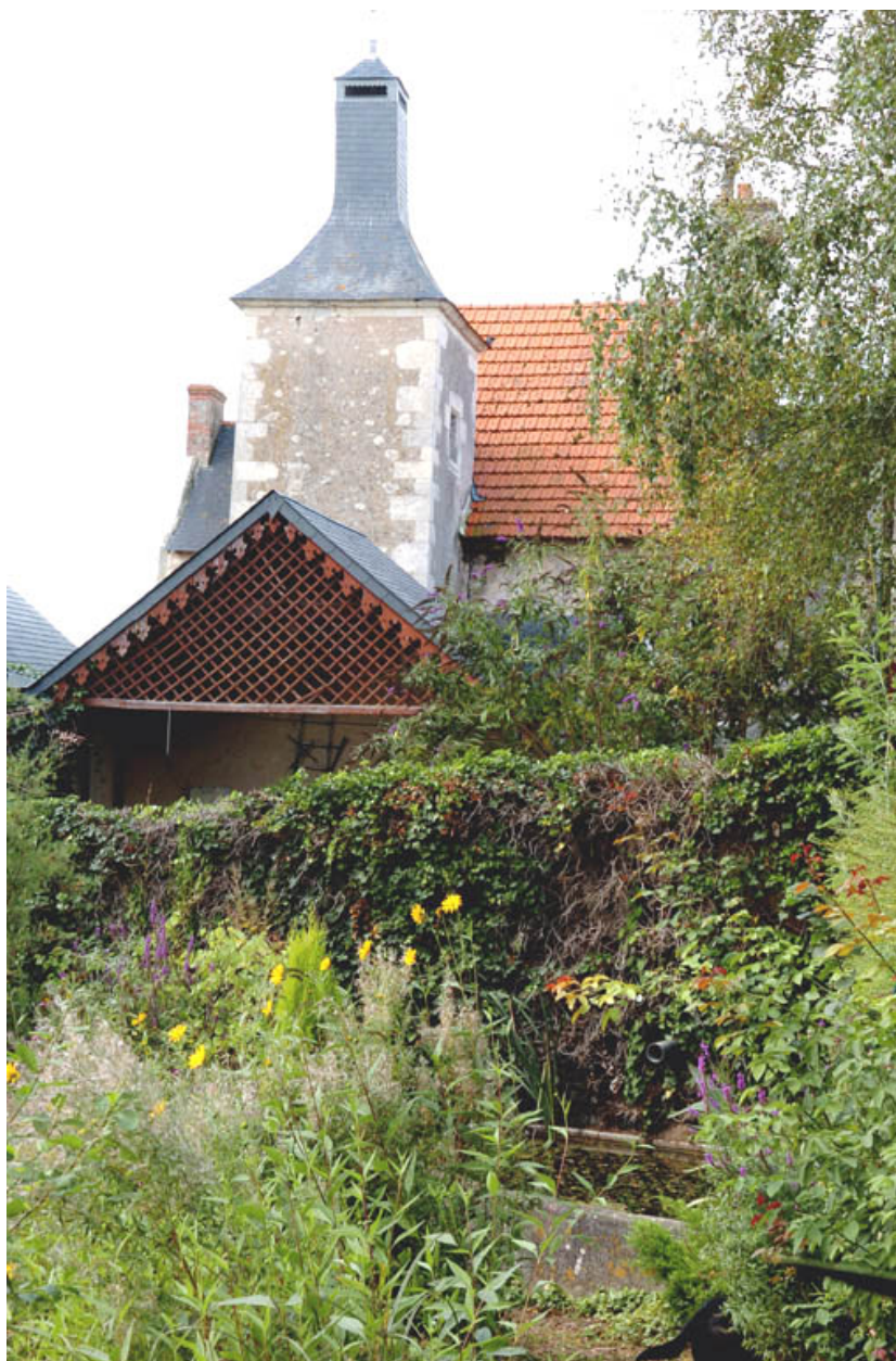
Vue de volume de la tourelle d'escalier.
