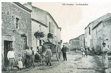
La maison, à gauche, vers 1900.
