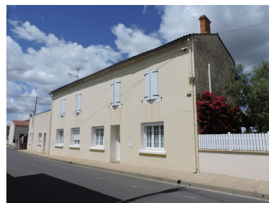
La maison vue depuis le sud-est.
