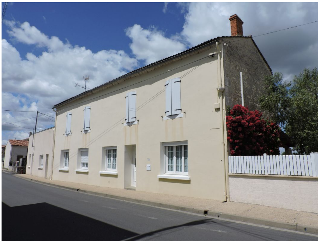
La maison vue depuis le sud-est.
