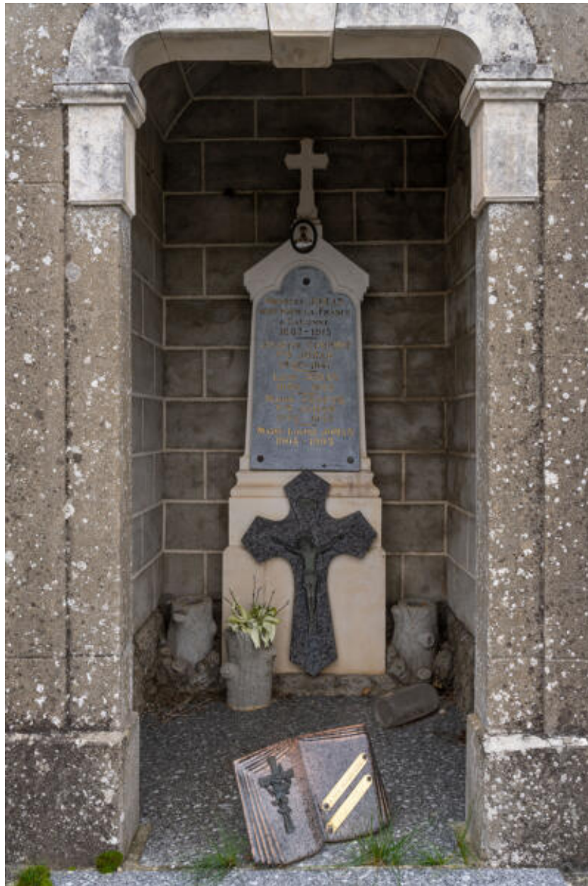
Tombe en forme de niche construite en béton avec décor de ciment rustiqué (détail).
