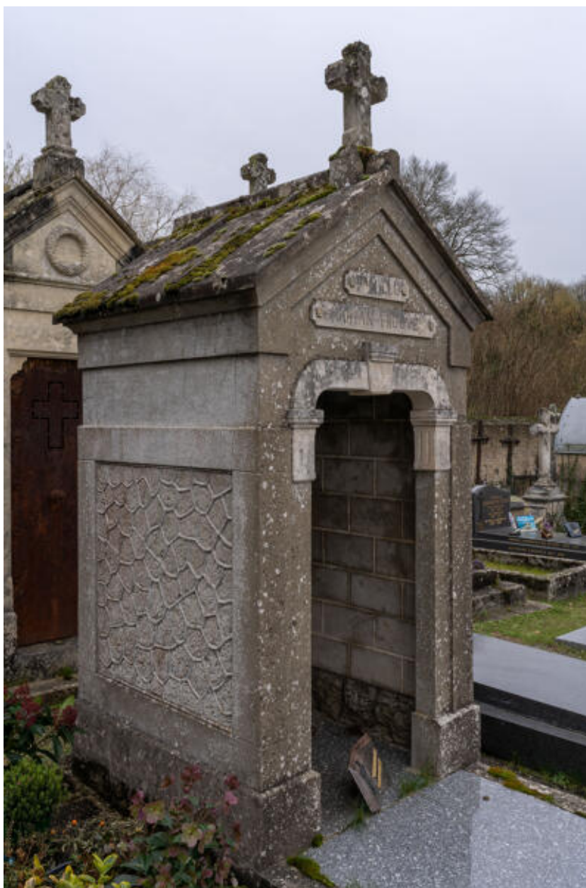
Tombe en forme de niche construite en béton avec décor de ciment rustiqué.
