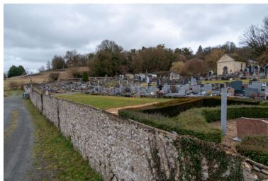
Vue d'ensemble avec le mur de clôture depuis le sud-ouest. Phot. Jeanne Minier IVR52_20267200121NUCA
