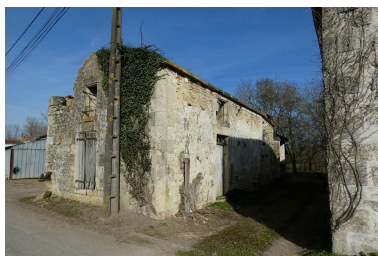
Les vestiges de la ferme vus depuis le sud-ouest. Phot. Yannis Suire IVR52_20238500714NUCA
