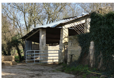
Le hangar à piliers en pierre vu depuis le nord-ouest. Phot. Yannis Suire IVR52_20238500717NUCA
