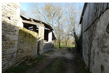
Le hangar à piliers en pierre et l'allée menant à la route d'eau. Phot. Yannis Suire IVR52_20238500716NUCA
