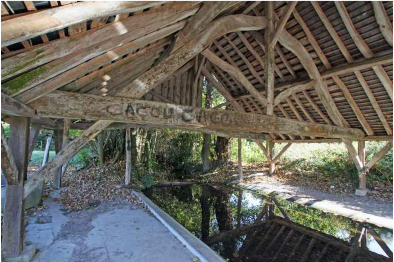
Intérieur : vue vers l'amont.
