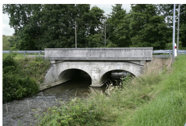
Vue d'aval depuis la rive gauche. Phot. François Lasa IVR52_20075300381NUCA
