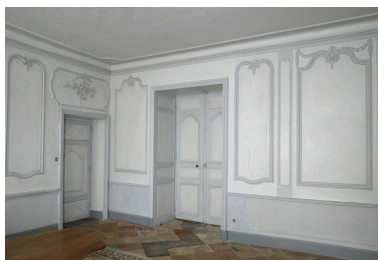
Premier salon à droite de l'entrée : vue d'ensemble Phot. Patrice Giraud IVR52_20068500166NUCA
