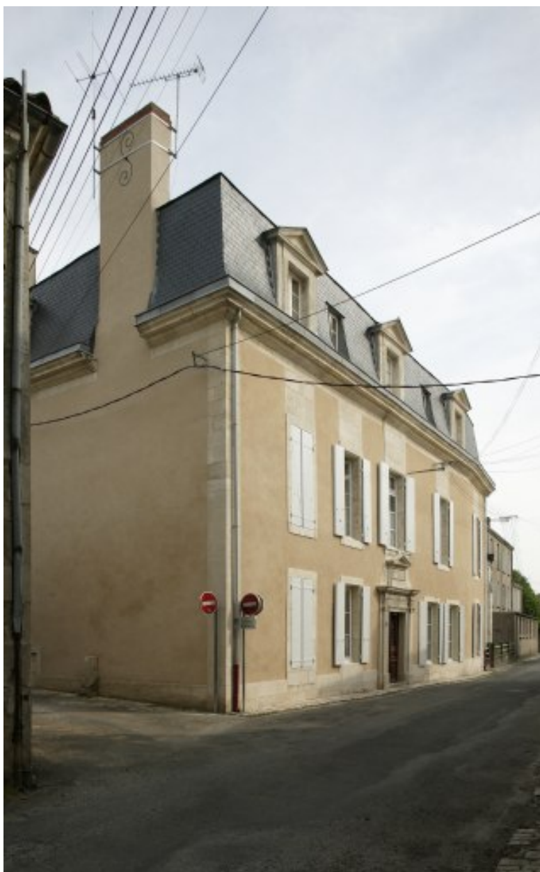
Vue de volume montrant la façade, rue Millesouris.
