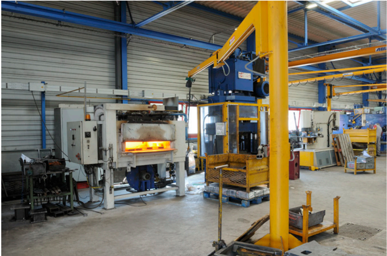
Usine Grégoire-Besson : forge.
