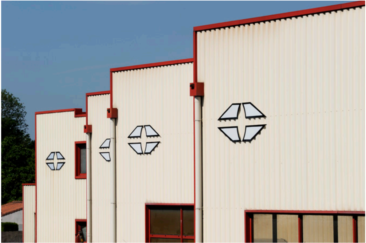
Usine Grégoire-Besson : atelier mécano-soudure et bureaux.
