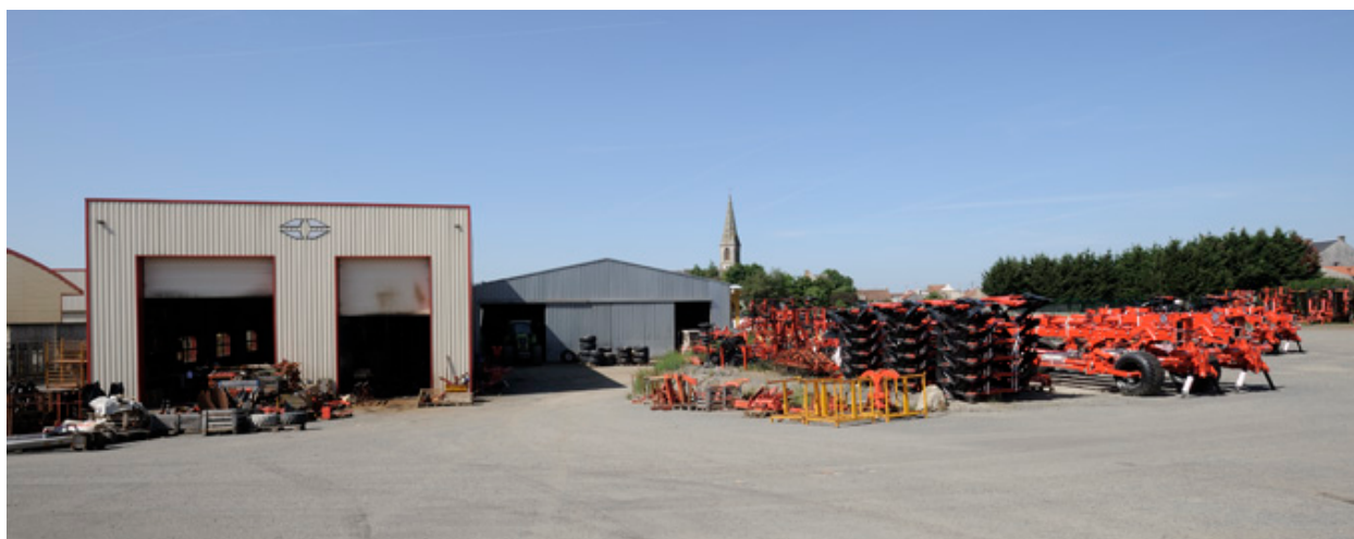
Usine Grégoire-Besson : vue depuis nord-est.
