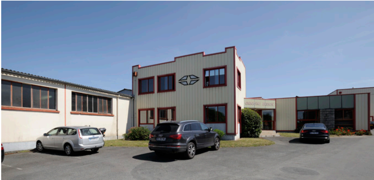
Usine Grégoire-Besson : accueil et bureaux.
