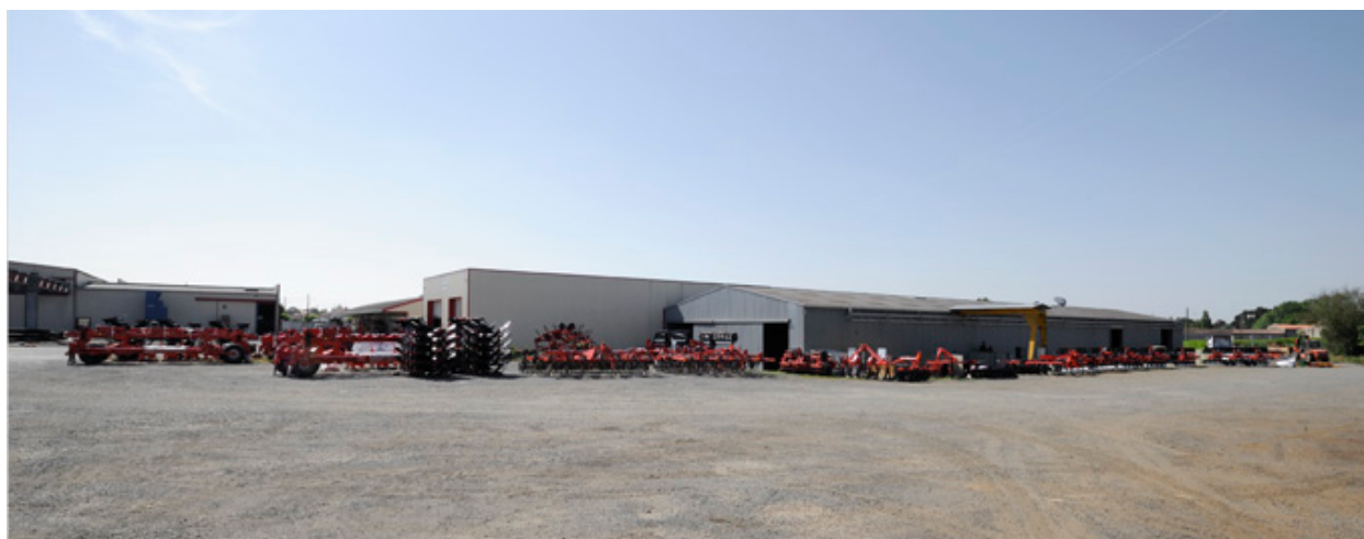
Usine Grégoire-Besson : vue depuis le nord.
