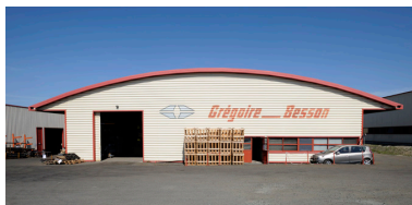
Usine Grégoire-Besson : bâtiment pour le stockage des pièces détachées. Phot. Bruno Rousseau, Phot. Youenn Communeau IVR52_20114901814NUCA
