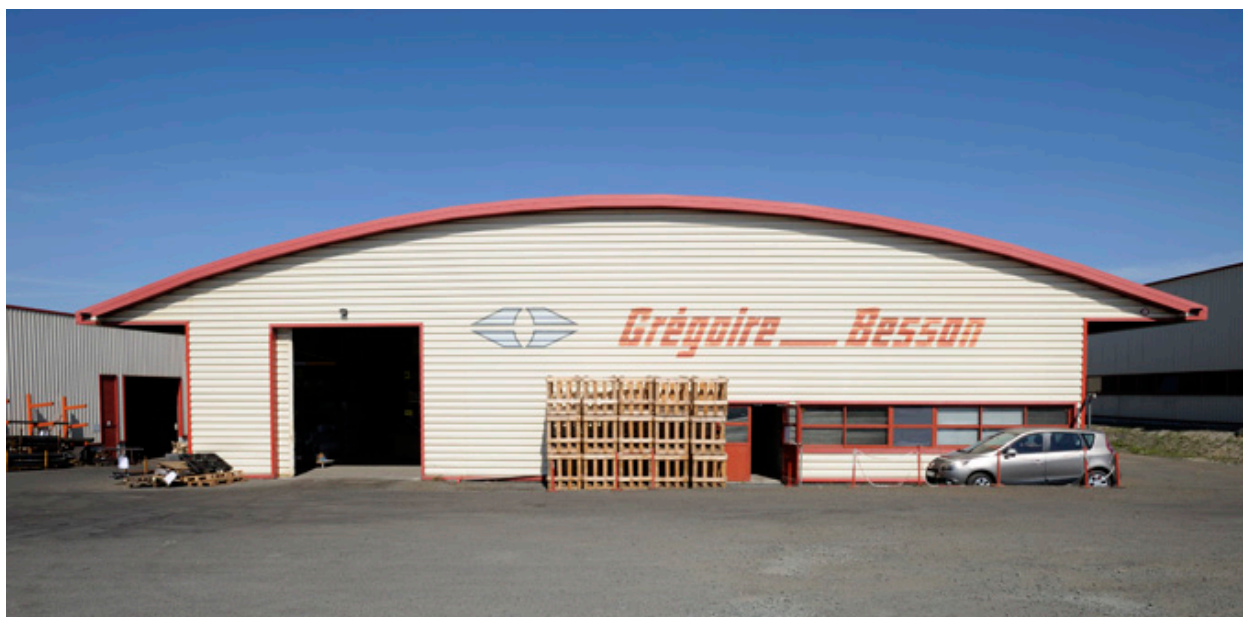
Usine Grégoire-Besson : bâtiment pour le stockage des pièces détachées.
