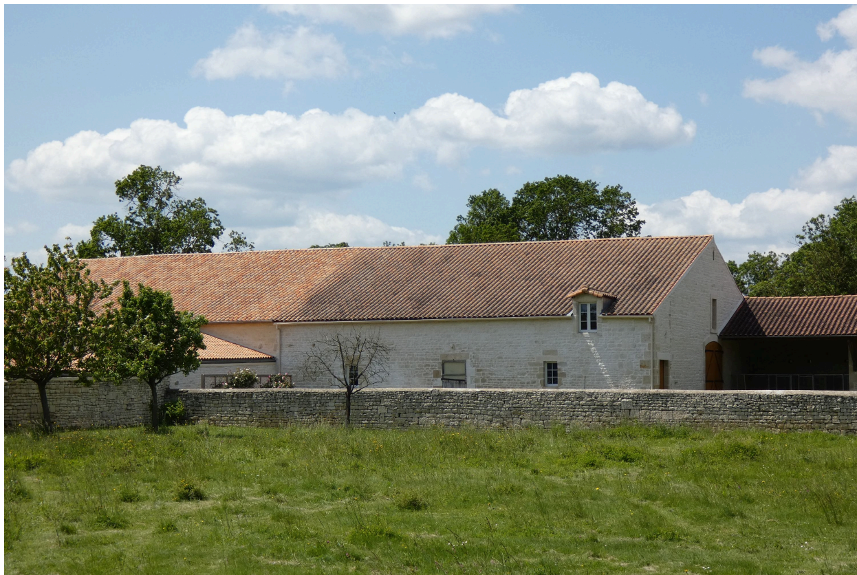
La grange-étable à façade en pignon vue depuis l'est.
