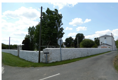
La propriété et son clos de mur vus depuis le nord-est. Phot. Yannis Suire IVR52_20238501516NUCA
