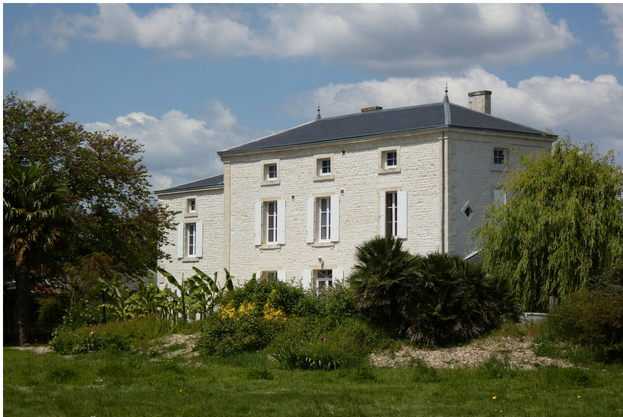
Le logis vu depuis le sud-est.
