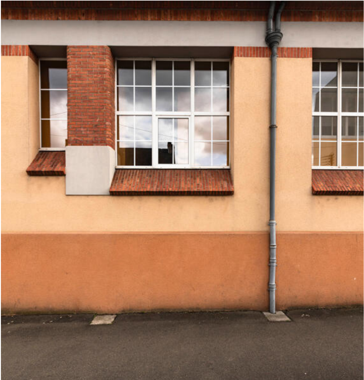
Détail de fenêtres avec allège de brique.
