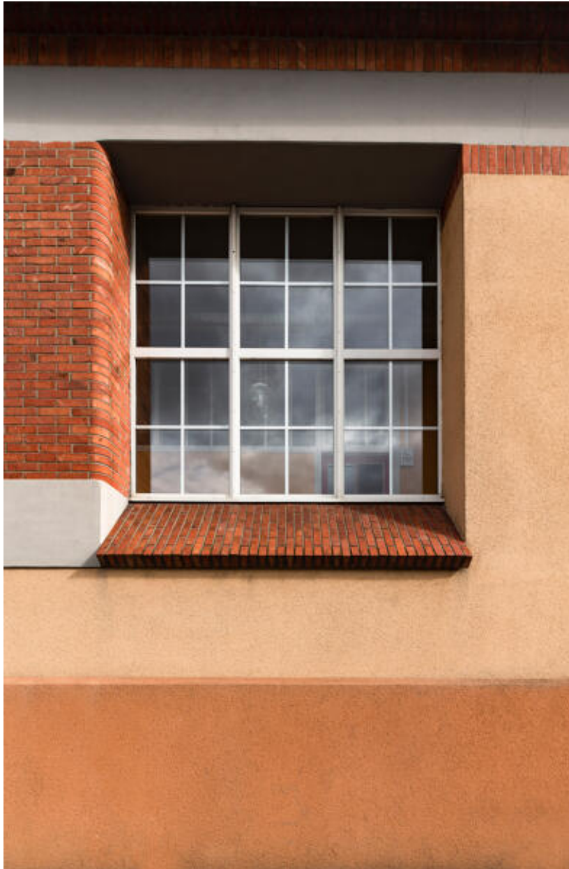
Détail d'une fenêtre sur la façade ouest de l'école.
