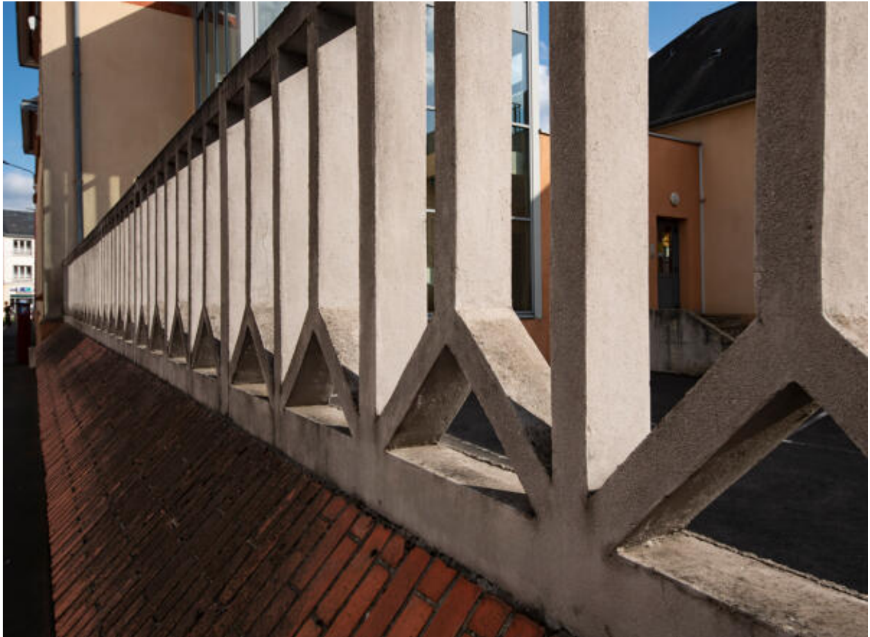
Détail de la clôture béton sur la partie nord de l'école.
