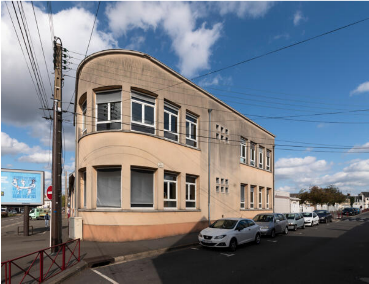
Vue de l'aile en retour sud reconstruite.
