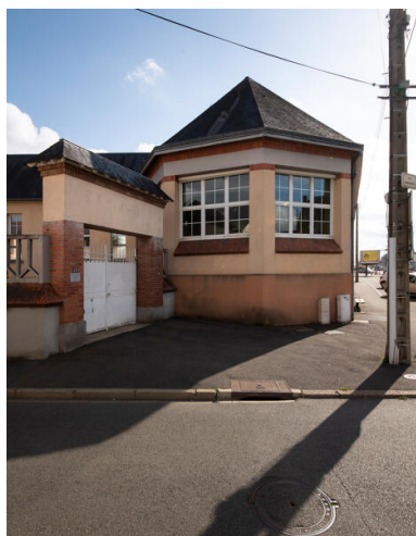
Vue du portail d'entrée ouest depuis la rue. Phot. Thierry Seldubuisson IVR52_20227201251NUCA
