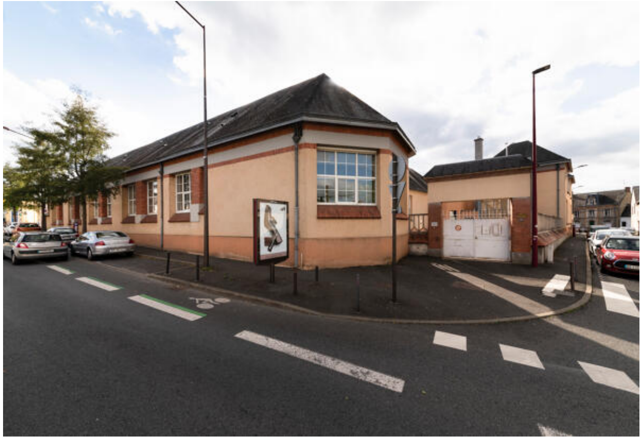
Vue de l'angle nord-est de l'école depuis la rue.
