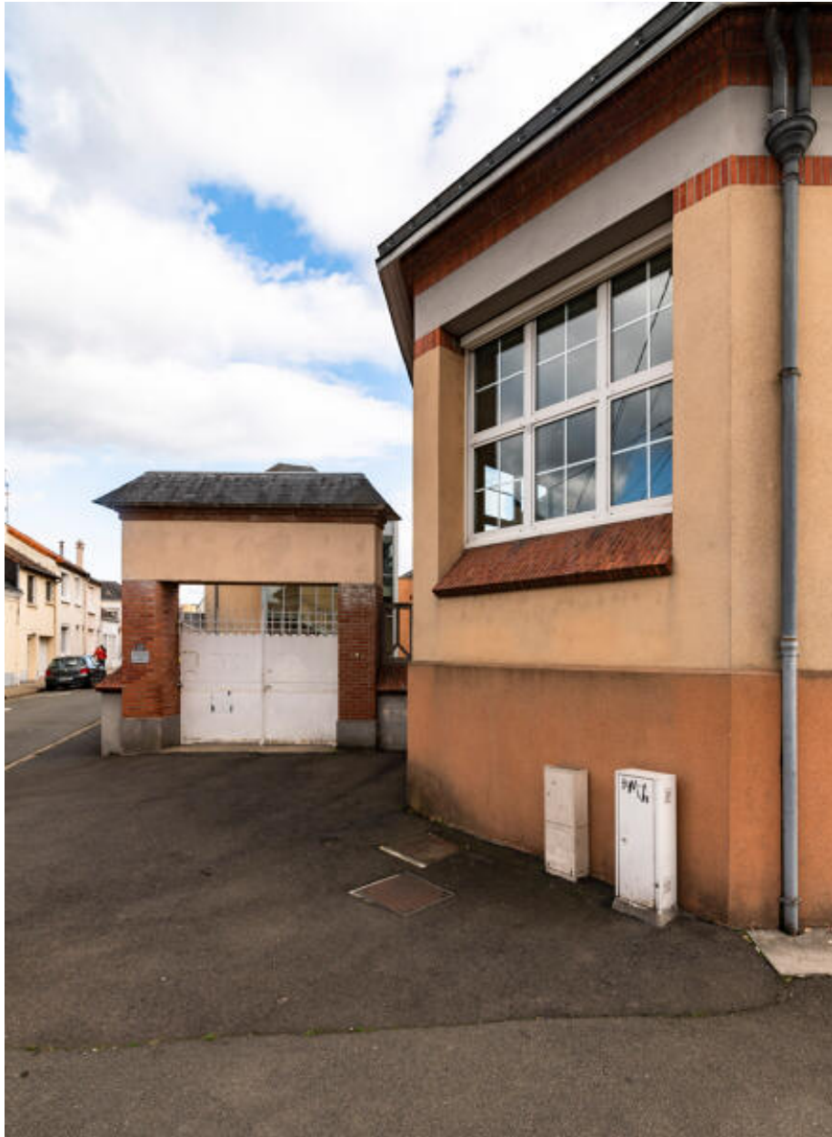
Vue du portail d'entrée est de l'école.
