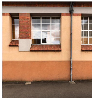
Détail de fenêtres avec allège de brique. Phot. Thierry Seldubuisson IVR52_20227201257NUCA
