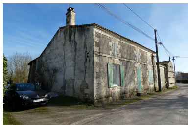
Vue depuis le nord-ouest. Phot. Yannis Suire IVR52_20238500712NUCA
