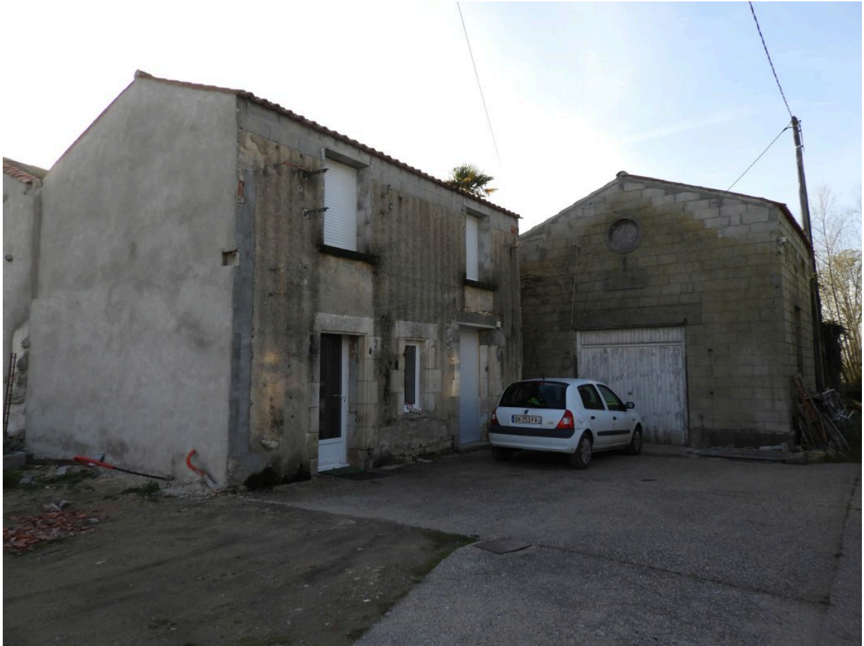
Le logement et l'ancien abattoir vus depuis l'est.
