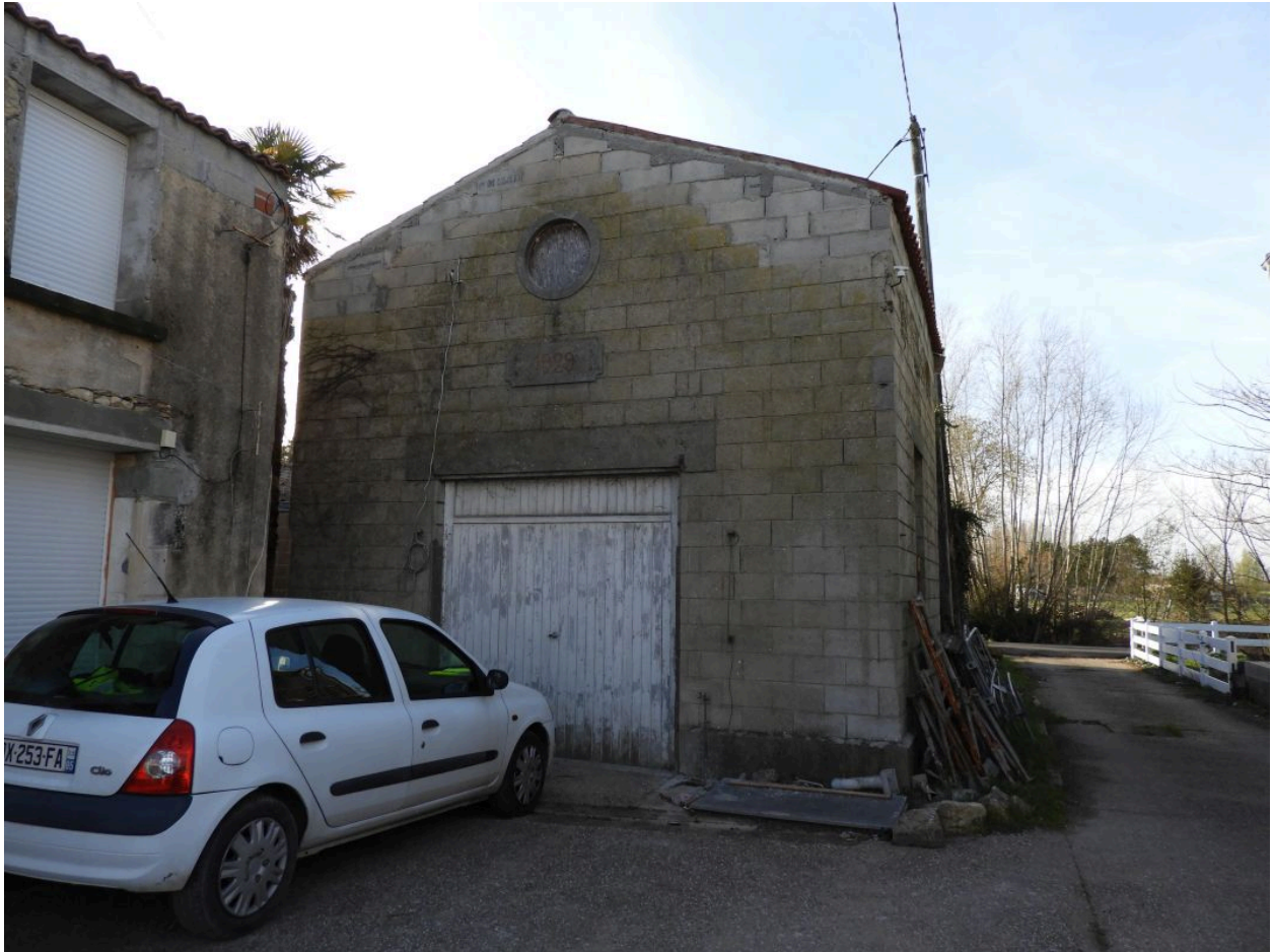
L'ancien abattoir vu depuis l'est.
