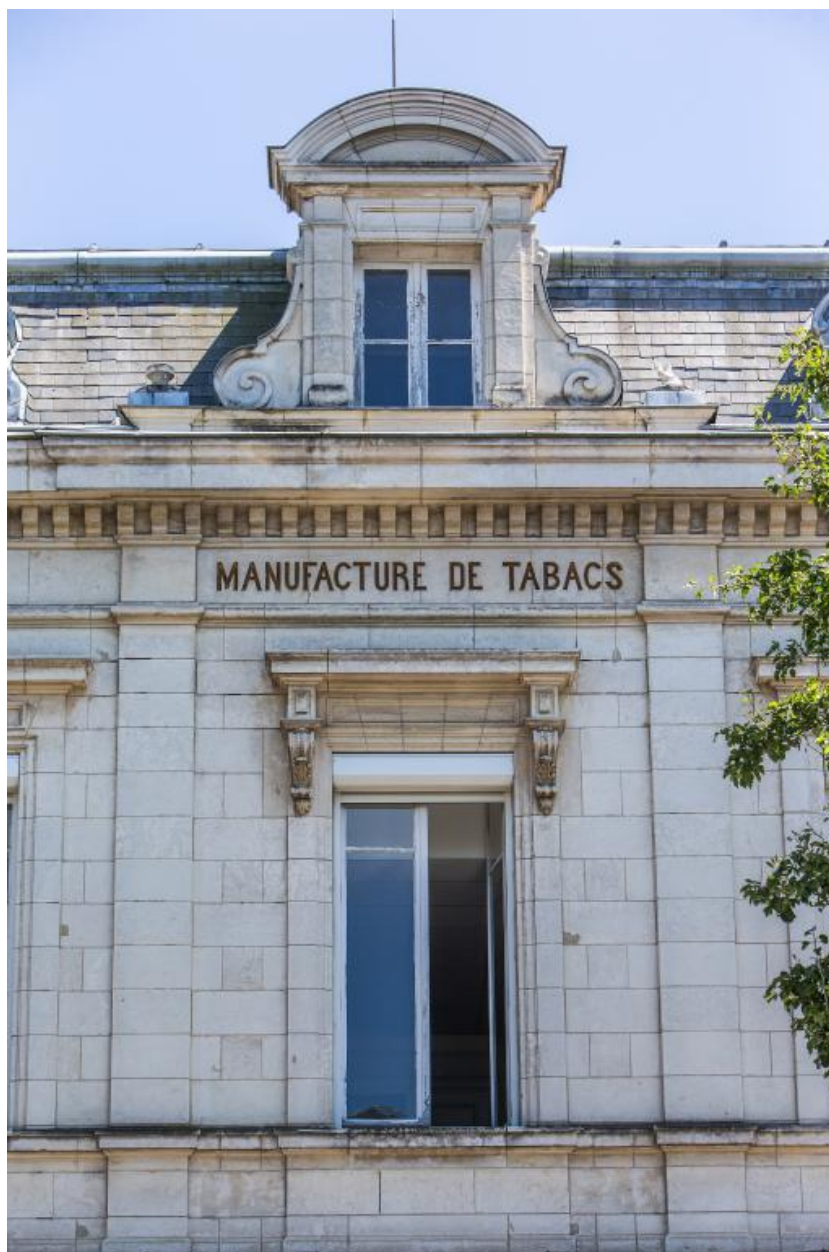
Vue de la travée principale de la manufacture des tabacs.
