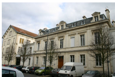
bureau de l'usine. Phot. Jonathan Truillet IVR52_20057200904NUCA
