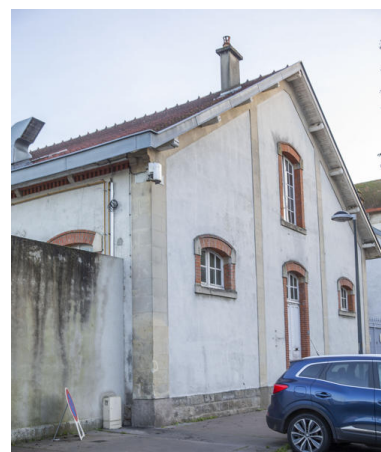
Vue du pignon de l'atelier nord- ouest de la manufacture depuis la rue. Phot. Pierre-Bernard Fourny IVR52_20197202769NUCA
