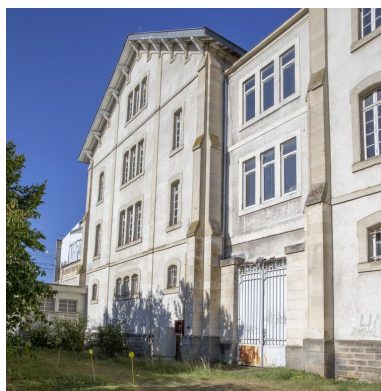
Vue du pignon est depuis l'ancien chemin de halage. Phot. Pierre-Bernard Fourny IVR52_20197202125NUCA
