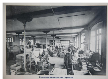
Feuillet de présentation de la manufacture des tabacs du Mans - atelier de paquetage mécanique, 1909. Repro. Pierre-Bernard Fourny IVR52_20197202899NUCA
