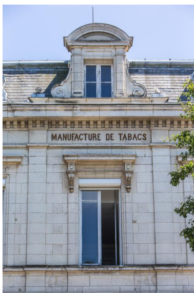
Vue de la travée principale de la manufacture des tabacs. Phot. Pierre-Bernard Fourny IVR52_20187200983NUCA
