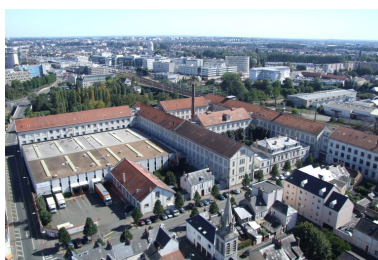
Elévation antérieure d'un des ateliers de fabrication. Phot. Jonathan Truillet IVR52_20057200901NUCA
