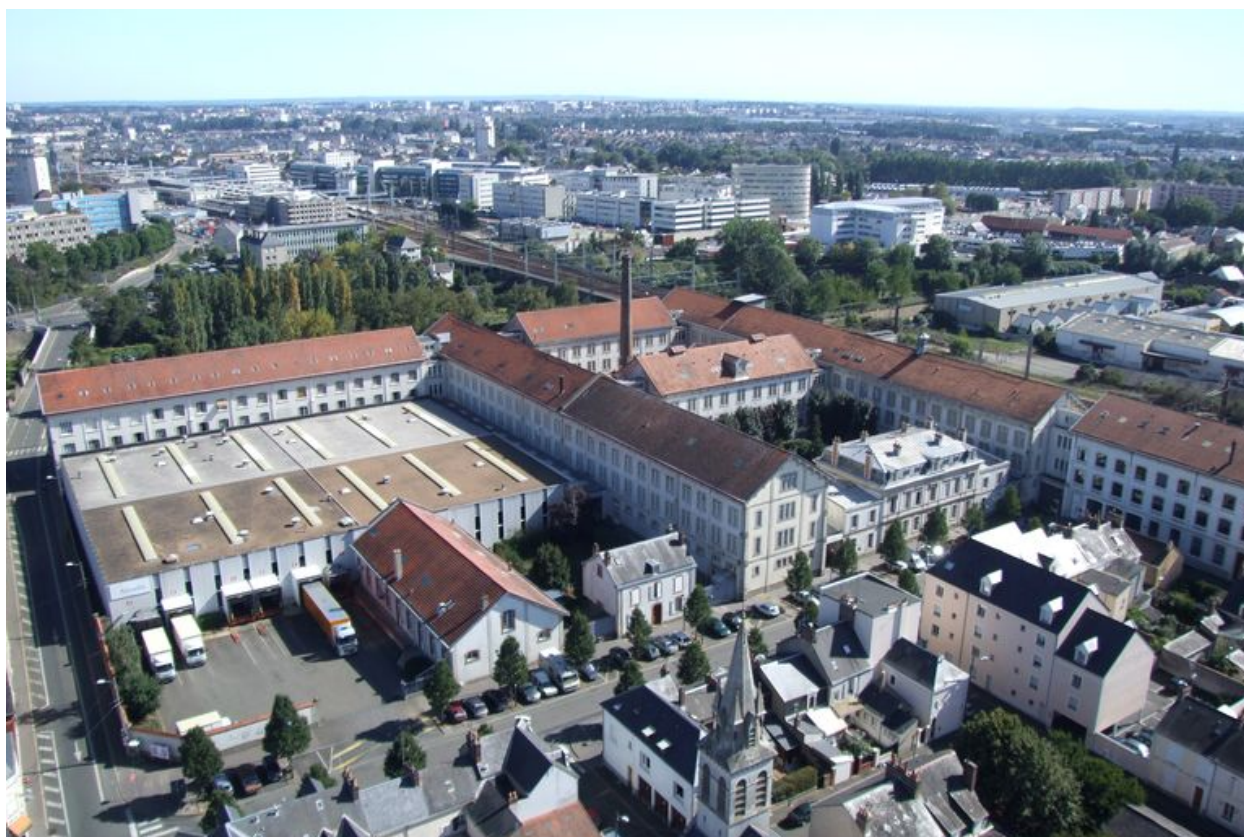
Elévation antérieure d'un des ateliers de fabrication.
