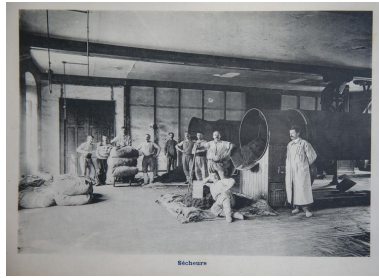
Feuillet de présentation de la manufacture des tabacs du Mans - séchage, 1909. Repro. Pierre-Bernard Fourny IVR52_20197202900NUCA
