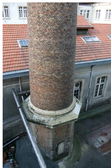
Soubassement de la cheminée d'usine. Phot. Jonathan Truillet IVR52_20057200903NUCA
