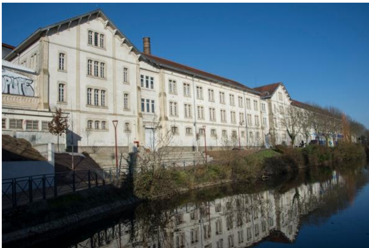
Vue de la façade côté Sarthe depuis l'île aux Planches.
