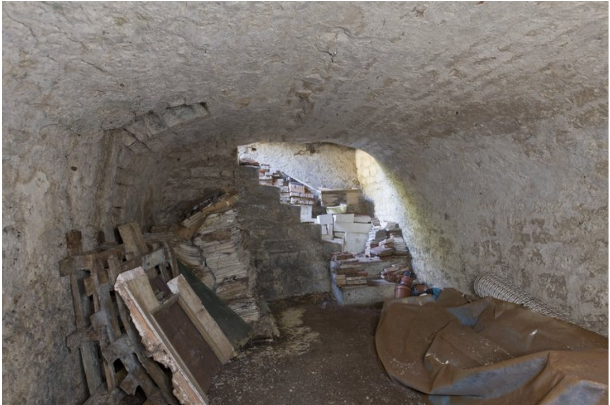
Sous-sol situé sous les dépendances au sud du jardin.
