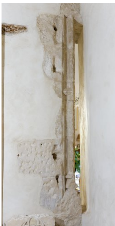
Vestiges d'une fenêtre du XVe siècle, à l'angle de la maison et de la dépendance au sud du jardin (vue prise de la dépendance, c'est-à-dire de l'extérieur).
