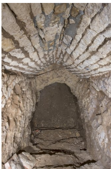
Sous-sol situé sous la partie nord de la maison. Phot. Patrice Giraud IVR52_20108500464NUCA
