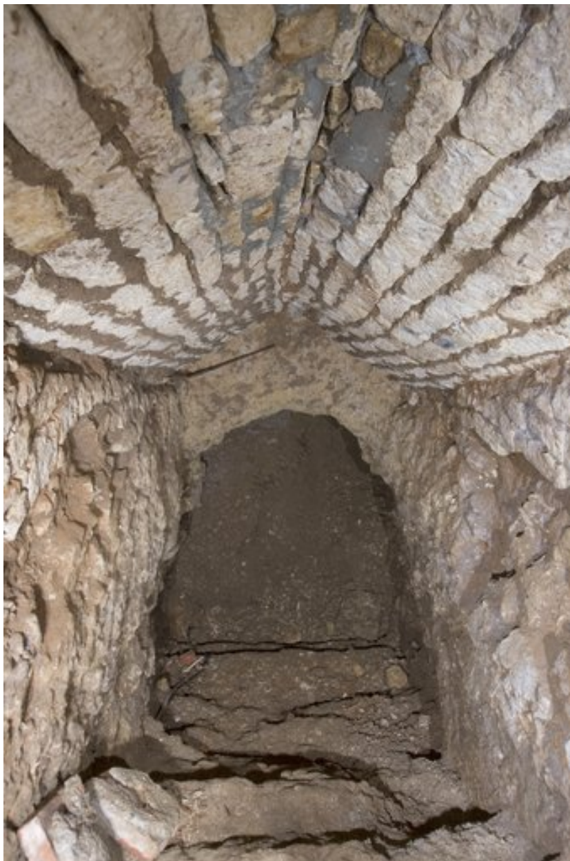
Sous-sol situé sous la partie nord de la maison.
