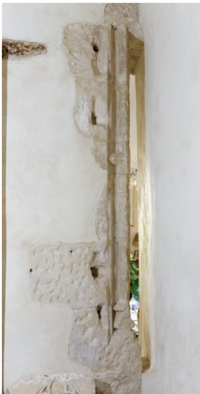
Vestiges d'une fenêtre du XVe siècle, à l'angle de la maison et de la dépendance au sud du jardin (vue prise de la dépendance, c'est-à-dire de l'extérieur).
