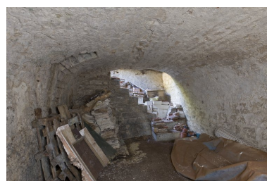
Sous-sol situé sous les dépendances au sud du jardin. Phot. Patrice Giraud IVR52_20108500468NUCA
