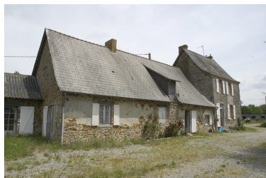
Les logis vus depuis le sud-ouest.
