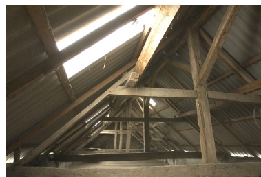
La charpente de l'étable-grange vue depuis le nord.
