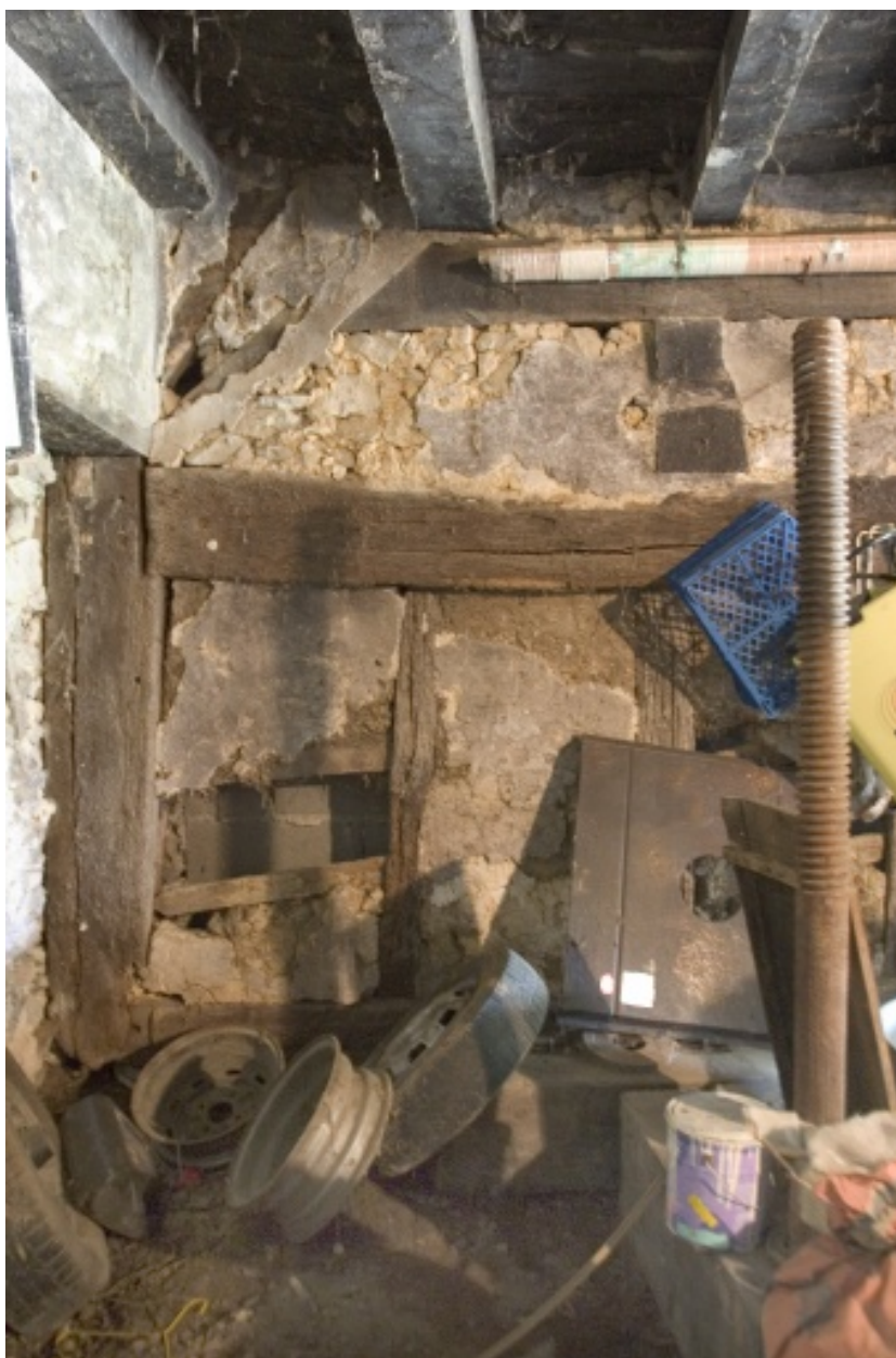
La cloison du logis de ferme vue depuis la pièce à cheminée à l'ouest.
