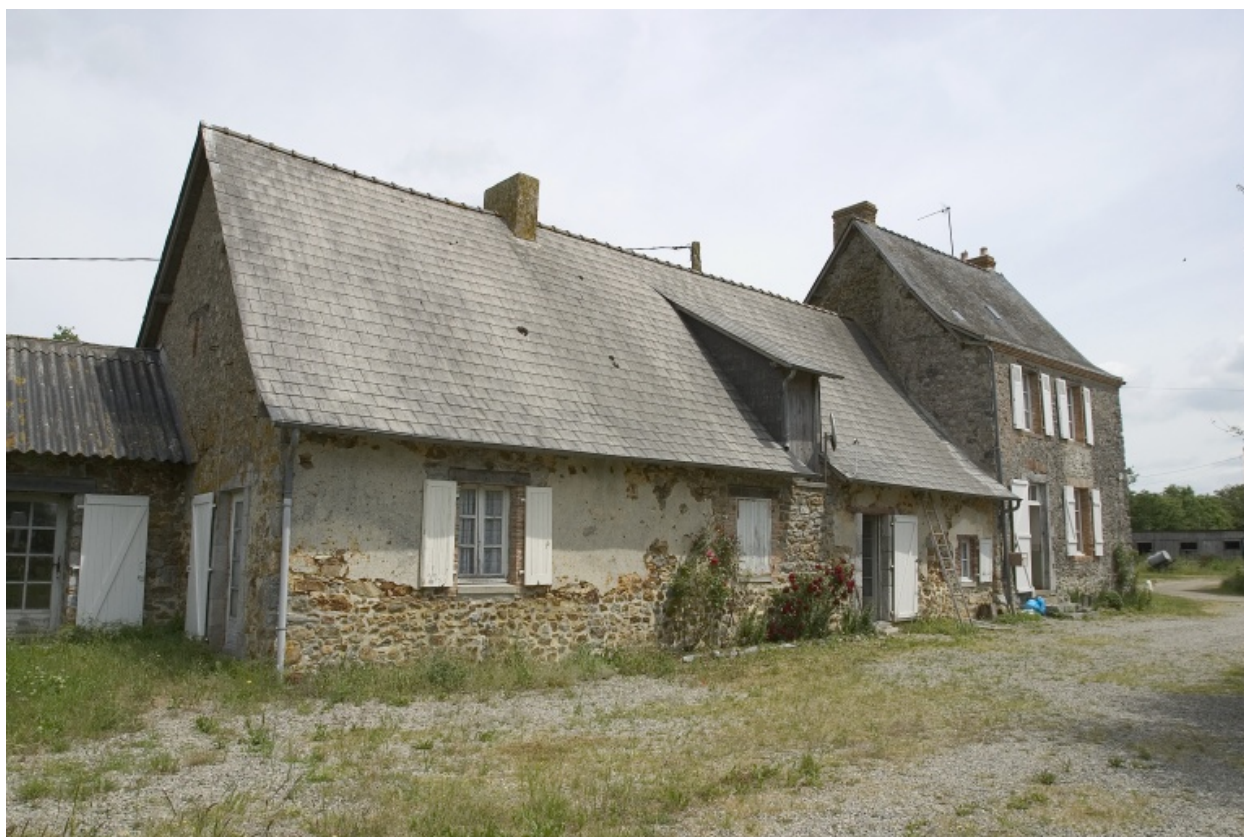
Les logis vus depuis le sud-ouest.
