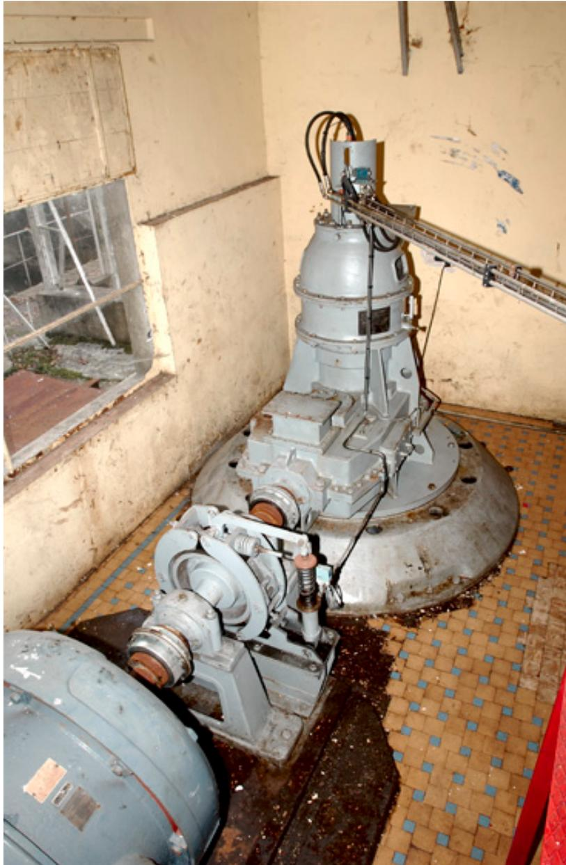
Turbine hydraulique, produisant une partie de l'électricité nécessaire au site.
