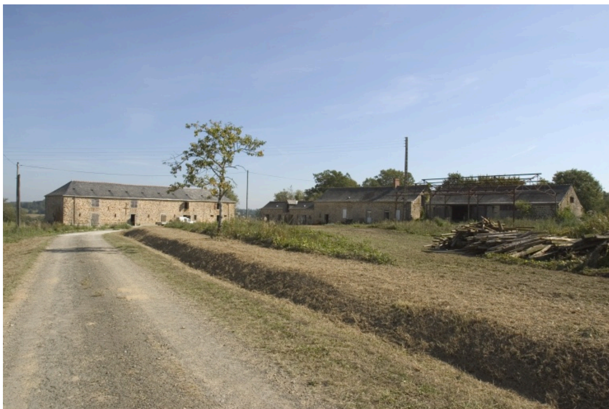
Vue d'ensemble depuis le chemin d'accès au sud-ouest.
