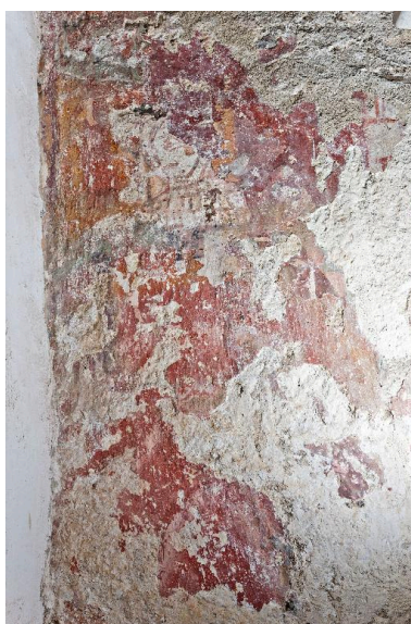
Bras sud du transept, mur nord, côté ouest. Couche picturale avec un soldat recouvrant le décor des années 1200. Phot. Yves Guillotin IVR52_20144900146NUCA
