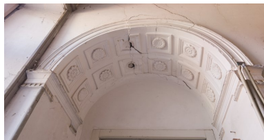
Détail du couloir de l'étage, longeant la façade ouest. Un autre arc est partiellement conservé. Phot. Patrice Giraud IVR52_20098500395NUCA
