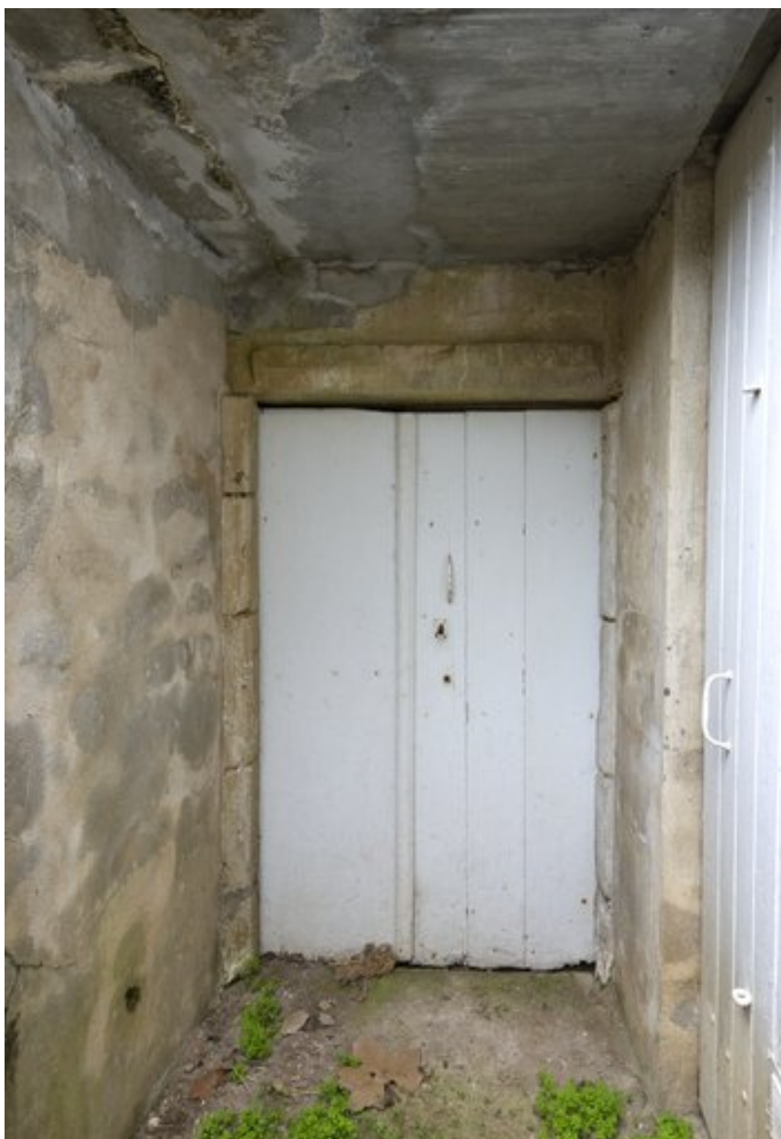
Porte d'accès au sous-sol, en retrait de la façade est.
