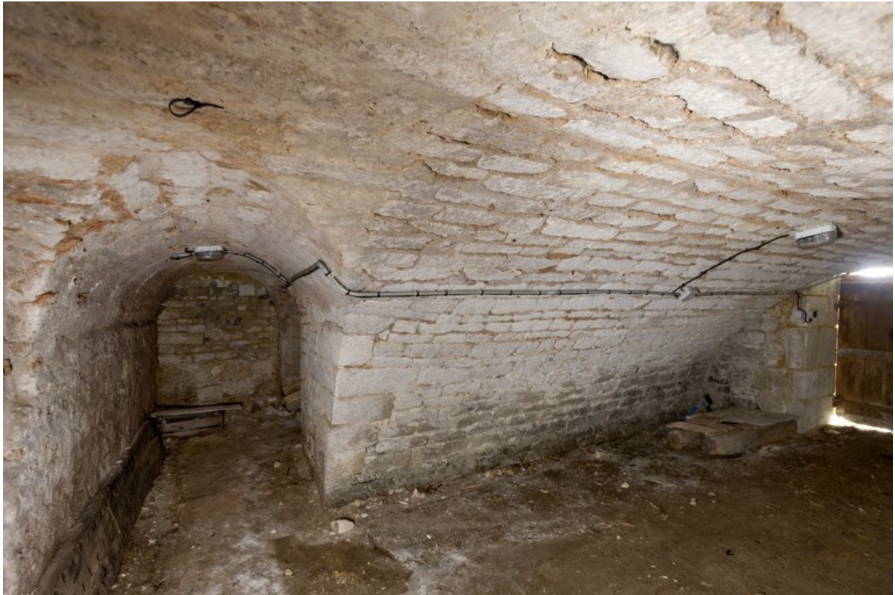
Vue du sous-sol prise du sud. Au fond à gauche, couloir muré suite à la division de la propriété (voir figure 13 pour la partie nord du couloir).
