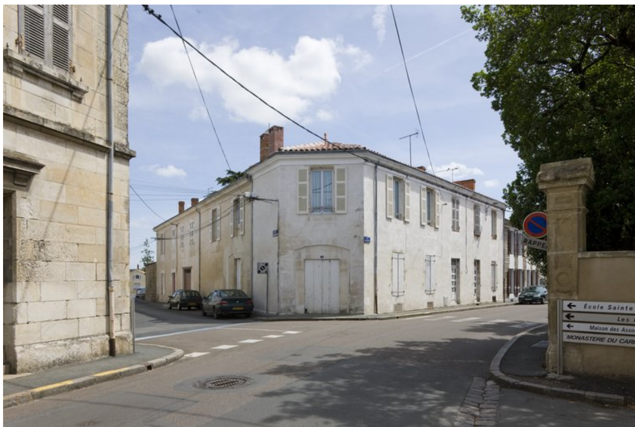
Vue de volume prise du nord-ouest, montrant les façades du XIXe siècle, rue de l'Union-Chrétienne et rue du Port.
