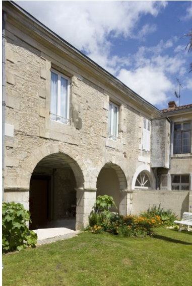
Partie est du bâtiment au nord de la cour (anciennes remises et écuries). Phot. Patrice Giraud IVR52_20098500284NUCA
