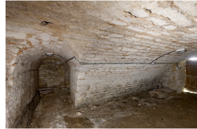
Vue du sous-sol prise du sud. Au fond à gauche, couloir muré suite à la division de la propriété (voir figure 13 pour la partie nord du couloir). Phot. Patrice Giraud IVR52_20098500266NUCA
