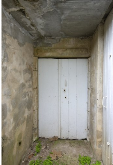
Porte d'accès au sous-sol, en retrait de la façade est. Phot. Patrice Giraud IVR52_20098500267NUCA
