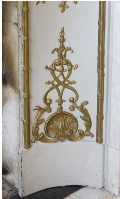
Décor du rétrécissement ébrasé de la cheminée du salon. Phot. Patrice Giraud IVR52_20098500399NUCA
