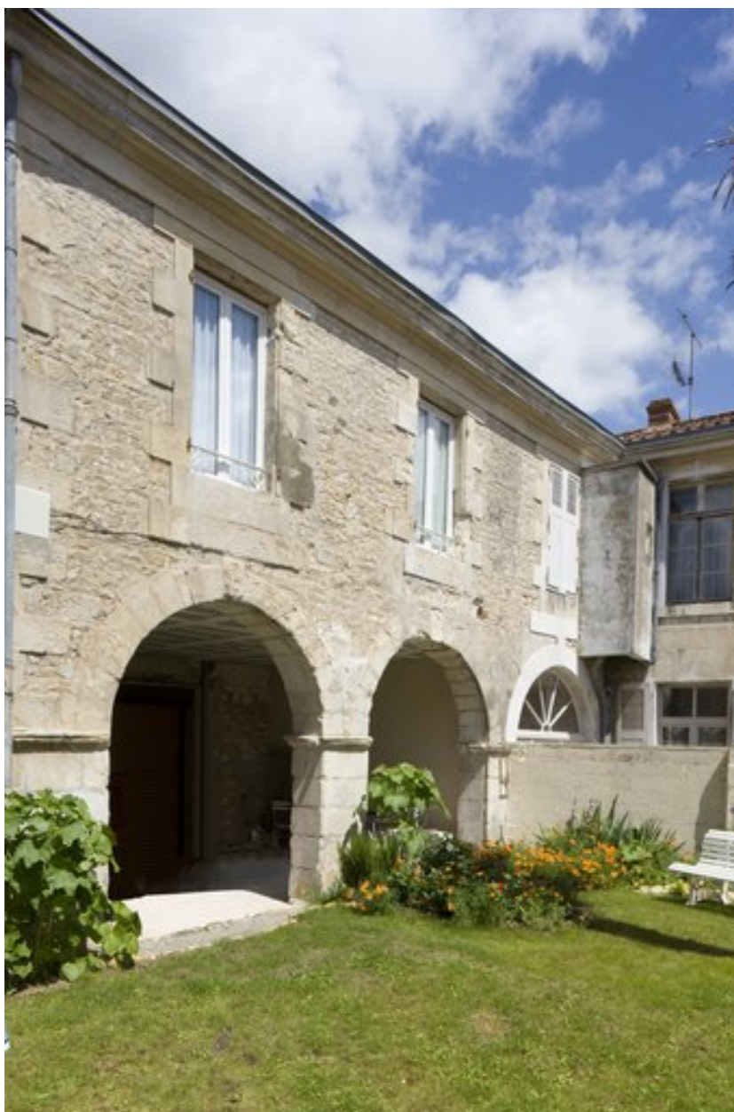
Partie est du bâtiment au nord de la cour (anciennes remises et écuries).
