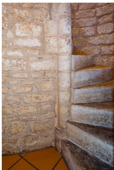
Départ de l'escalier en vis (vue prise du sous-sol). Phot. Patrice Giraud IVR52_20118500249NUCA
