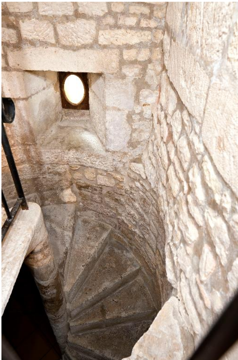
Vue plongeante de l'escalier en vis donnant accès au sous-sol.
