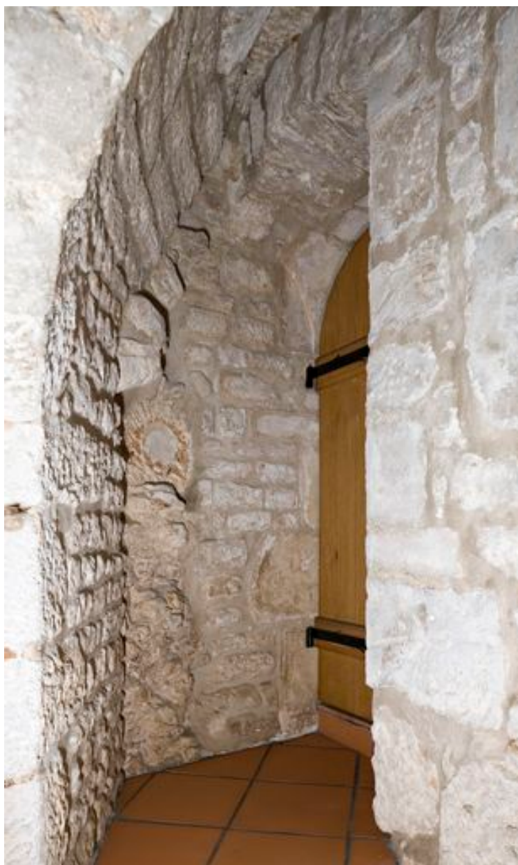
Vue prise du sous-sol, montrant l'accès à l'escalier en vis. Noter l'arrière-voussure de Marseille.
