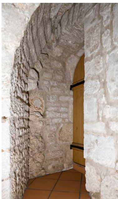
Vue prise du sous-sol, montrant l'accès à l'escalier en vis. Noter l'arrière-voussure de Marseille. Phot. Patrice Giraud IVR52_20118500248NUCA
