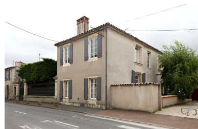
Vue de la demeure prise du nord-ouest. L'entrée se trouve sur la façade est, perpendiculaire à la rue. Phot. Patrice Giraud IVR52_20118500255NUCA
