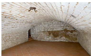
Vue du sous-sol prise du nord. Au fond à gauche, accès à l'escalier en vis menant au rez-de-chaussée. Phot. Patrice Giraud IVR52_20118500247NUCA
