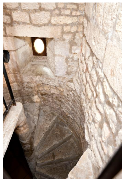
Vue plongeante de l'escalier en vis donnant accès au sous-sol. Phot. Patrice Giraud IVR52_20118500250NUCA
