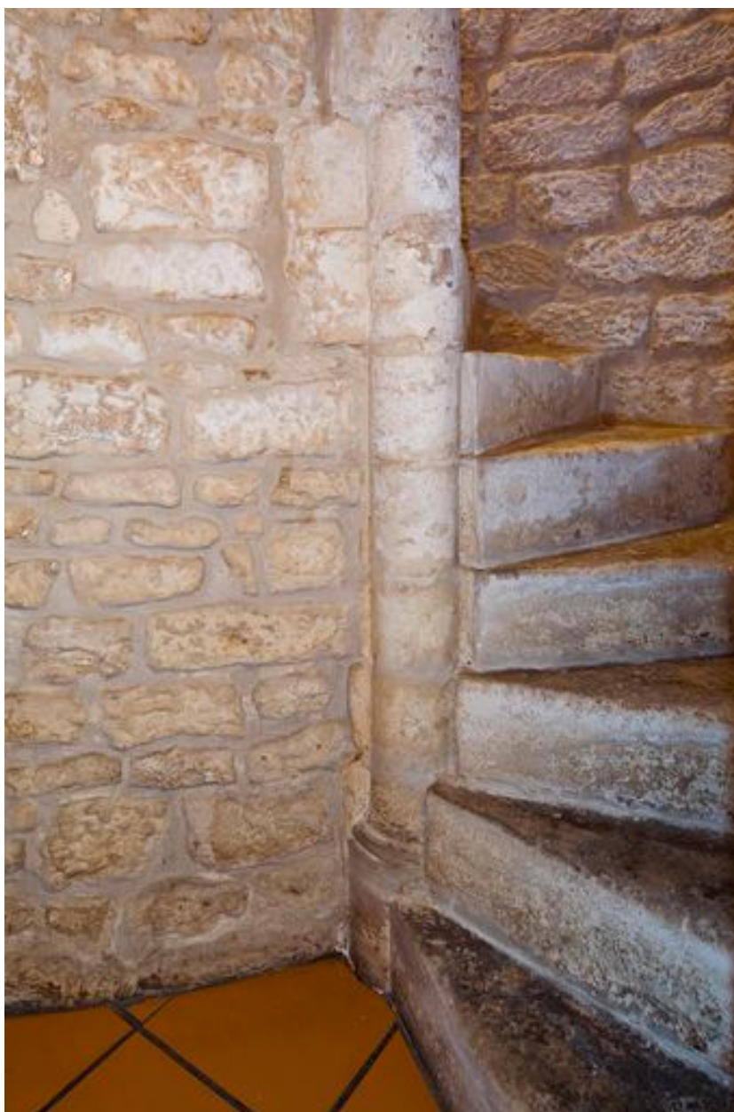
Départ de l'escalier en vis (vue prise du sous-sol).
