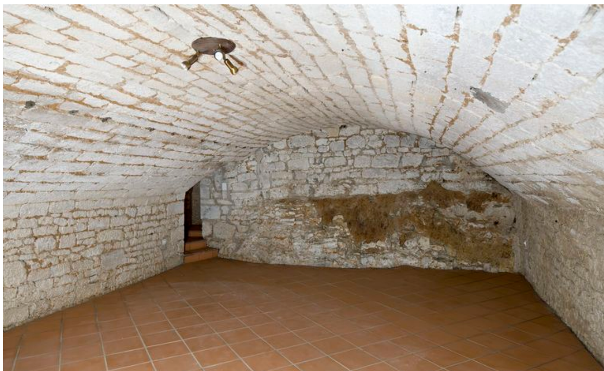
Vue du sous-sol prise du nord. Au fond à gauche, accès à l'escalier en vis menant au rez-de-chaussée.
