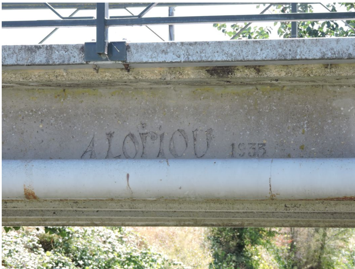
La signature A. Loriou et la date 1933 inscrites sur le tablier du pont, côté amont.
