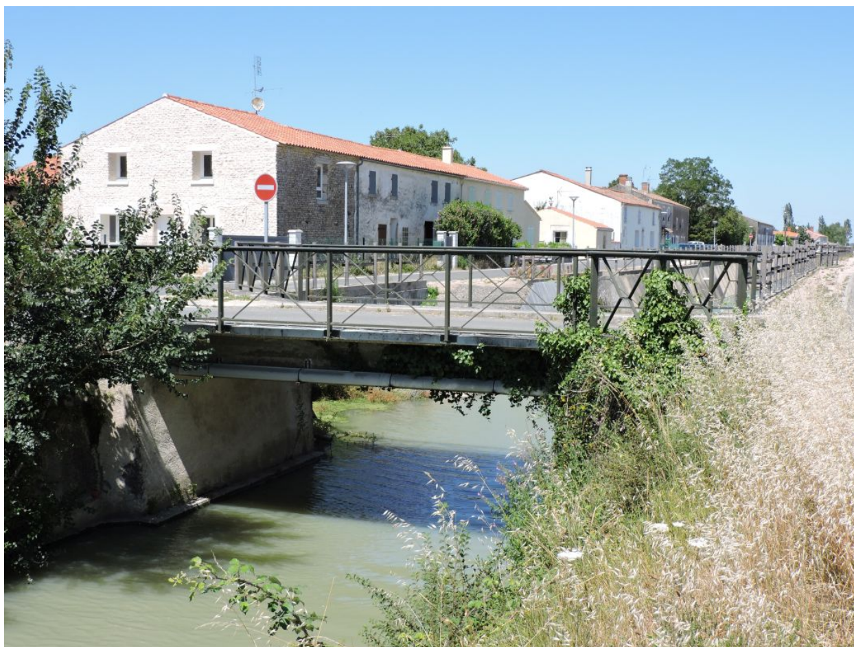
Le pont vu depuis l'aval, au sud.
