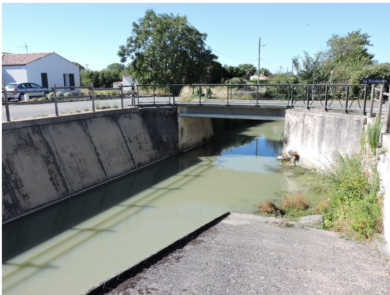
Le pont vu depuis l'amont, au nord.
