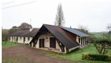
Vue d'ensemble. Phot. Thierry Seldubuisson IVR52_20247200423NUCA
